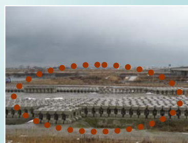
大河津橋下流の護床ブロックストックヤード(H20.2.12撮影)
