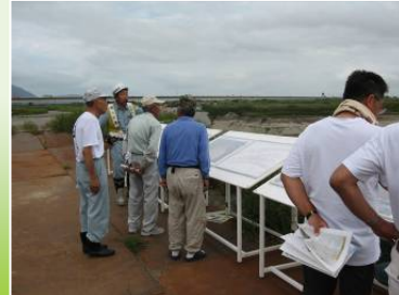
可動堰工事現場の見学
