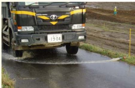
場内散水状況
