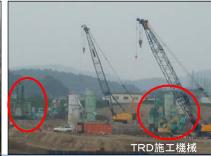
連続地中壁工 (TRD工法)
