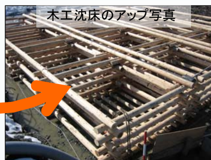
護岸・粗朶沈床・木工沈床 施工状況
