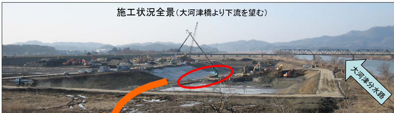
護岸・粗朶沈床・木工沈床 施工状況
