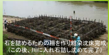
粗朶沈床の施工手順(概略)
