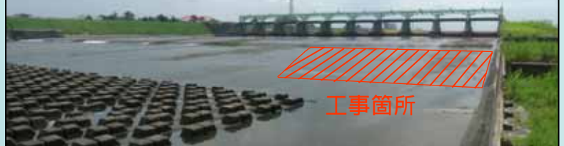
分水町五千石地先 (第一床固全景)
