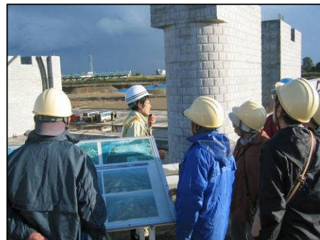
新可動堰の工事現場で進捗状況を説明している様子。
