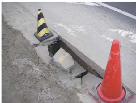
堤防の居住地側の陥没状況です。アスファルトが裂け、陥没しています。
