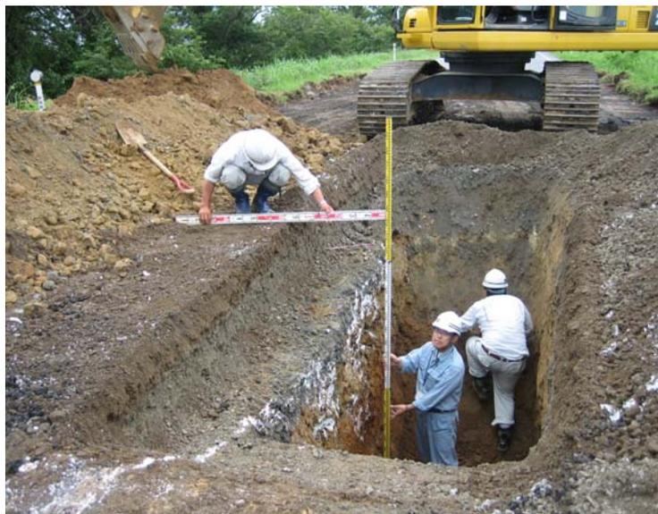
亀裂の部分を含め、この部分で約230cm掘削しました。白い部分は亀裂の深さを確認するための石灰で、深いところまで亀裂が入ったことが分かります。
