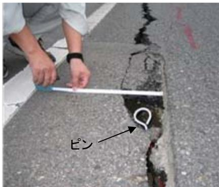
亀裂状況：ピンが全て入ってしまうため、亀裂の深さは100cm以上あります。
