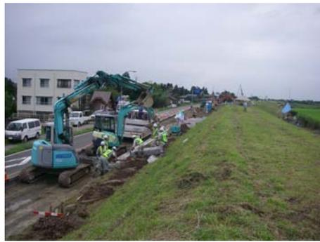
L型側溝を道路の路肩に設置しています。
