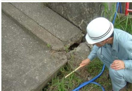
高水護岸の中折れ部分です。沈下により、護岸に開きができています。
