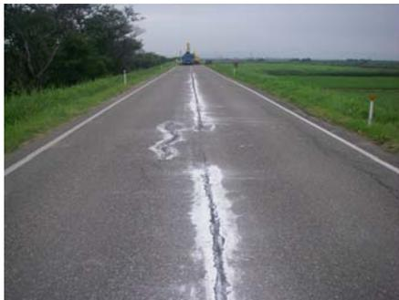
堤防上面に長く亀裂が入っています。(白くなっている部分は、亀裂の深さを確認するための石灰です。)
