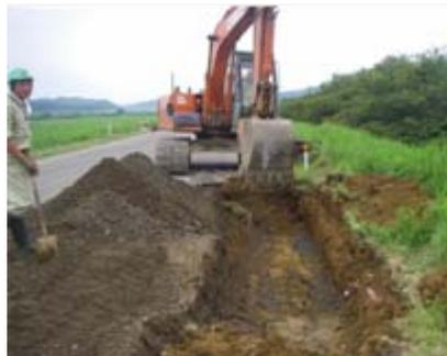
亀裂の部分を含め掘削しているところです。
