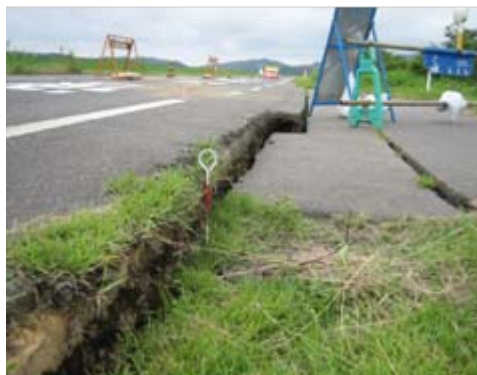
地震直後、堤防坂路の取付け部に生じた段差の様子です。
