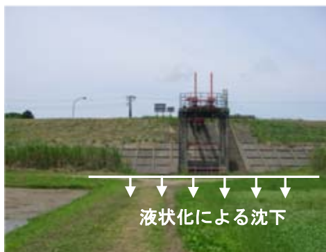
町軽井揚水機取水樋管周辺の被災
