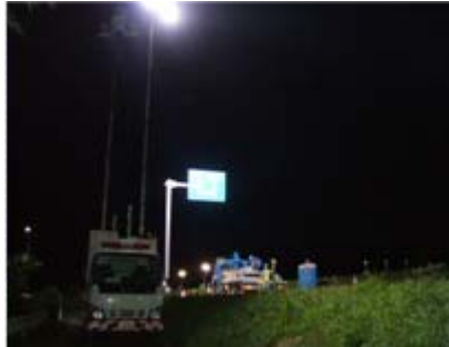
夜間、照明車に照らされた工事現場。
