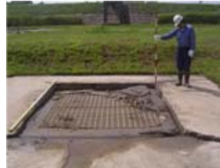
沈下・噴砂跡
