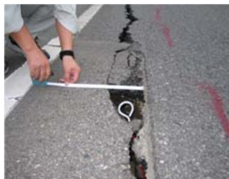
巡視の状況：亀裂の幅・深さを計測中
