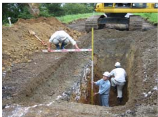
亀裂の部分を含め、この部分で約230cm掘削しました。亀裂の深さを確認するため投入した石灰が奥深くまで確認できます。
