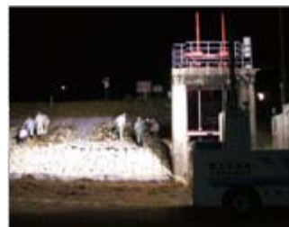
24時間体制で、「じゃかご」の設置を行いました。写真は照明車により照らされた現場の様子。
