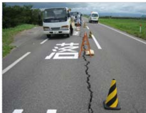
堤防上面に生じた亀裂
