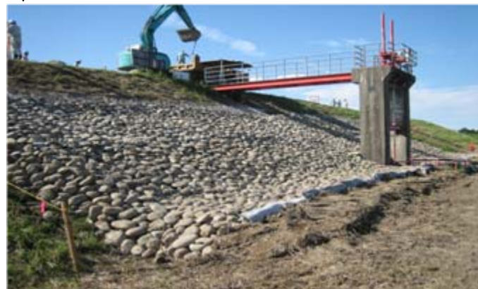
堤防護岸の前面に「じゃかご」を設置し、堤防としての機能を回復しました。
