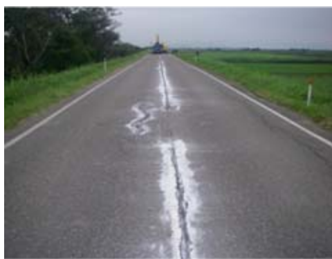
地震直後、堤防上面に生じた亀裂の深さを確認するため石灰を投入した後の様子です。
