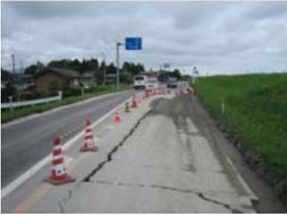
地震直後、堤防居住地側の兼用道路に亀裂が入った様子。
