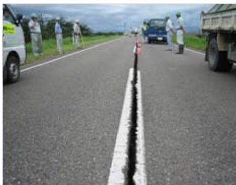
堤防上面に生じた亀裂
