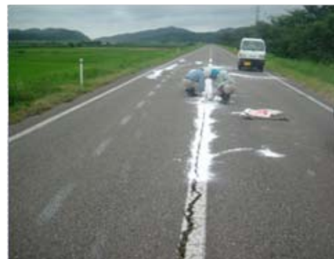
地震直後、堤防上面に生じた亀裂の深さを確認するため石灰を投入しているところです。
