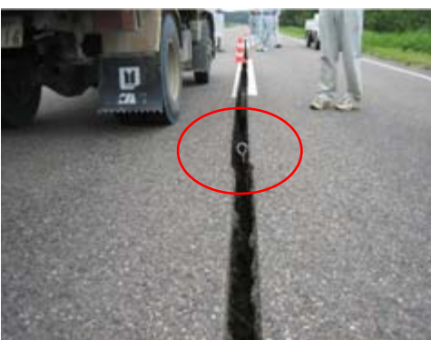
地震直後の亀裂の状況です。ピンが全部入ってしまうため、亀裂の深さは100cm以上あります。
