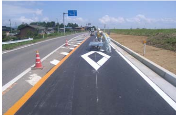
27日までの10日間で、切返し盛土・アスファルト舗装を実施し、堤防機能と道路機能を回復しました。写真は完成目前の区画線を設置しているところです。
