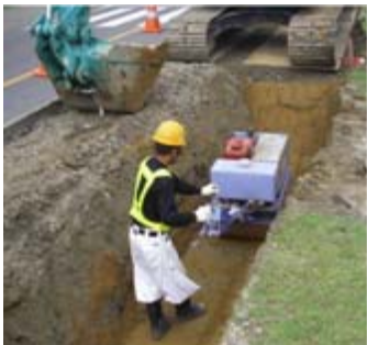
亀裂が入ったところまで掘削が完了し、再度念入りに締固めを行っているところです。
