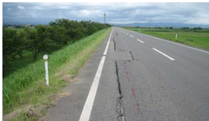
地震直後、堤防上面に亀裂が入った様子です。
