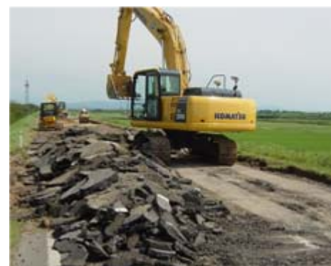
亀裂が生じた箇所の切返しを行うためアスファルトを撤去しています。
