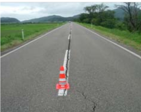
地震直後、堤防上面に亀裂が入った様子です。写真では分かりませんが、奥深くまで亀裂が入っています。
