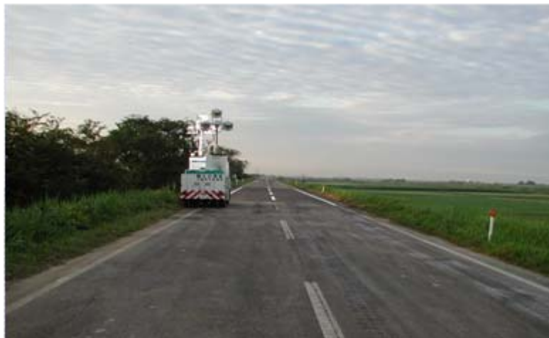
25日までの8日間で、切返し盛土・アスファルト舗装を実施し、堤防機能と道路機能を回復しました。
