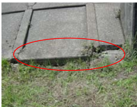
護岸の沈下・開き
