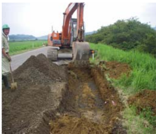
亀裂を確認しながら、バックホウで切返し盛土を行っているところです。
