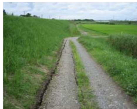
坂路に生じた亀裂
