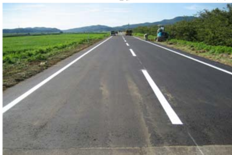
25日までの8日間で、切返し盛土・アスファルト舗装を実施し、堤防機能と道路機能を回復しました。
