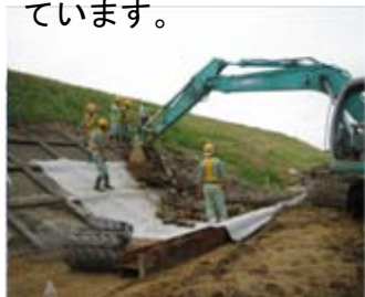
堤防護岸の中折れ部分です。沈下により、護岸に開きができています。
