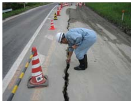
巡視の状況：亀裂の深さを計測中
