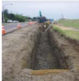
亀裂の部分を含め掘削をしているところです。
