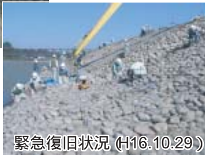
低水護岸の被害 (十日町市城之古地先)
