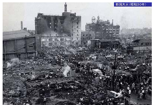
図 - 16 新潟大火(昭和30年)による状況
