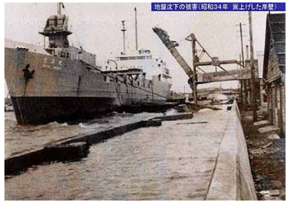
図 - 17 地盤沈下の被害(昭和34年)
