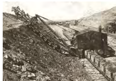
大河津分水路工事は、当時ではめずらしい土砂を掘る機械も使われました。
