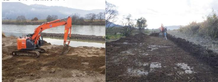
出水により地形変化が発生し、掘削土量の増加や堆積土砂の撤去費等が発生
