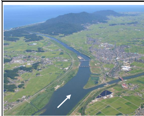
信濃川・大河津分水路を望む
