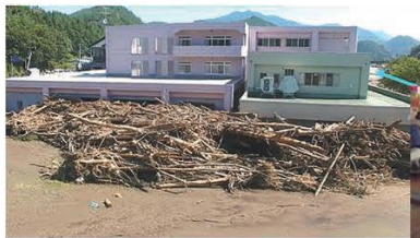
岩手県で被災した要配慮者利用施設
