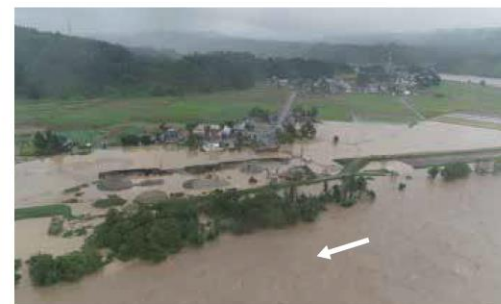
新潟県小千谷市内における浸水被害状況
