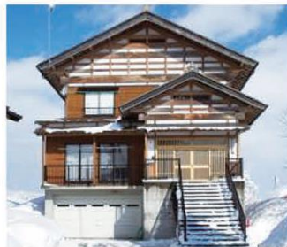
高床式住宅の事例 (新潟県十日町市)
