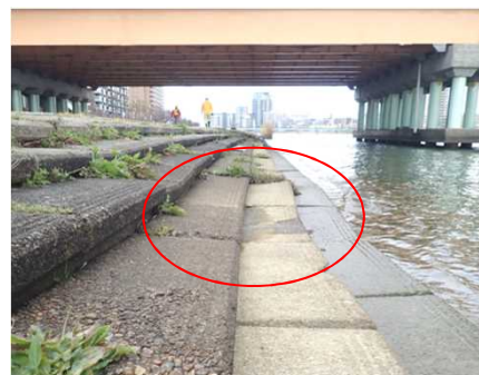
護岸ブロックの沈下
