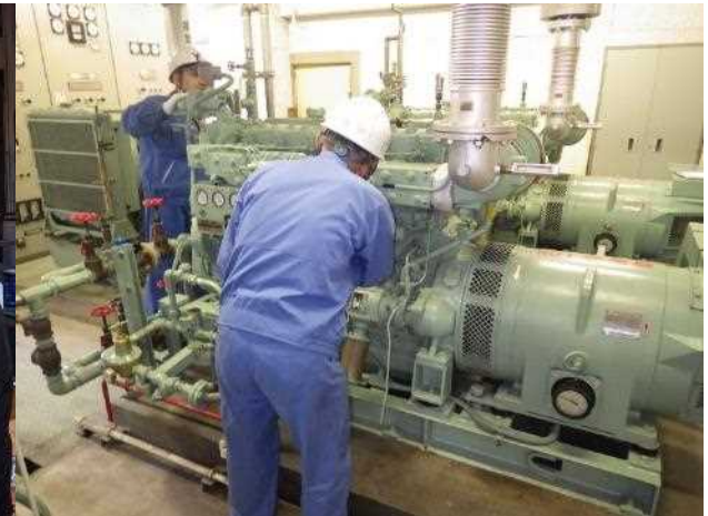
排水機場発電機点検
