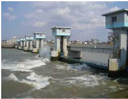
新潟大堰の全景
