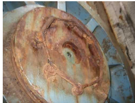
扉体主ローラ 分解整備
