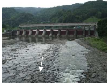
宮中取水ダム 試験放流前 (H13. 7. 19 放流量7.10m 3 /s)
