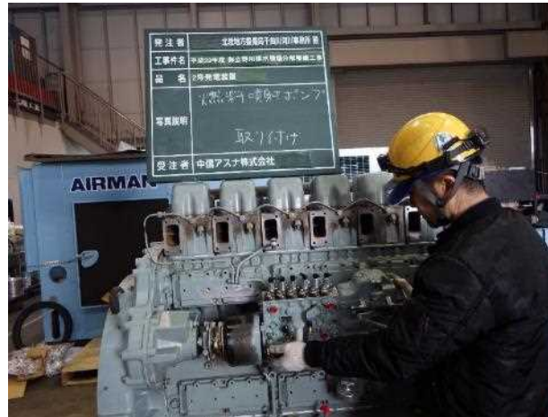
排水機場発電機整備
