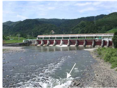
宮中取水ダム 試験放流 (H16. 8. 21 放流量22.65m 3 /s)
