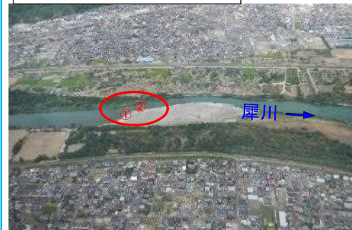
ヘリ空撮による流況調査(H30.8.7撮影)
