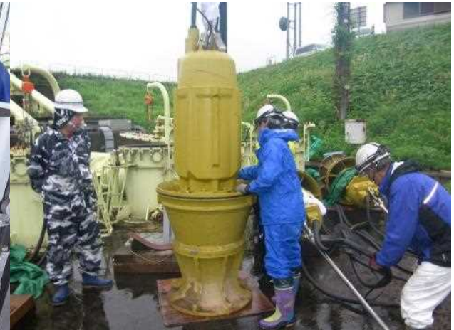
排水機場ポンプ点検
