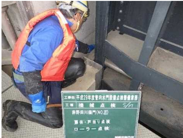
樋門ゲート点検
