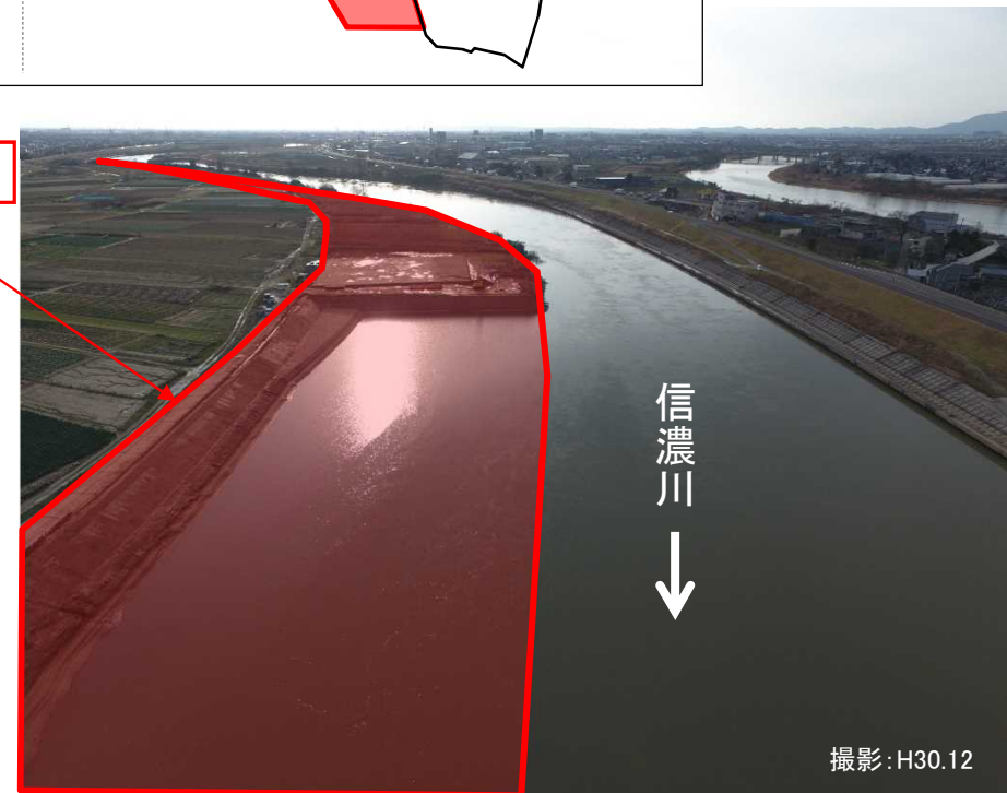
栗林地区 河道掘削状況
