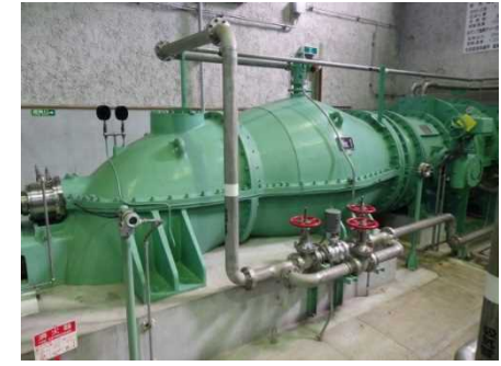
1号主ポンプ 外観
