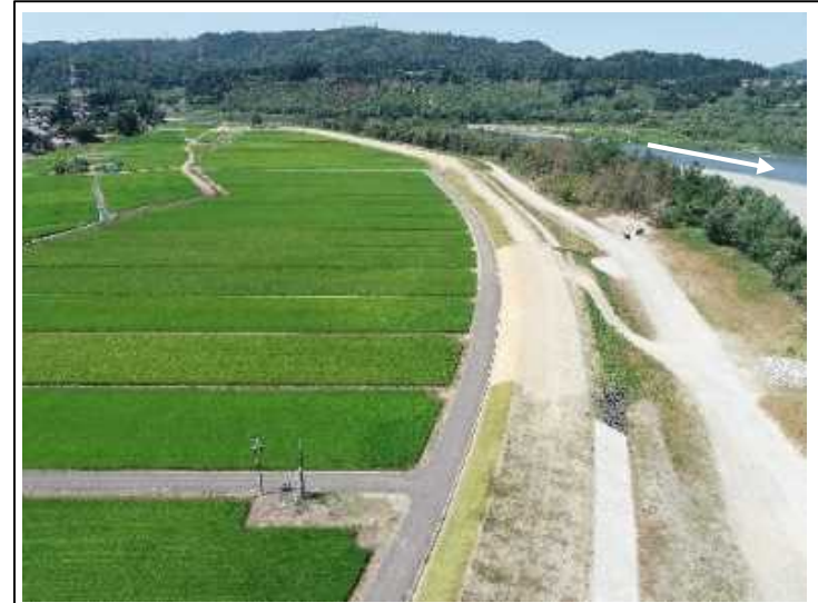
川井地区 築堤状況
