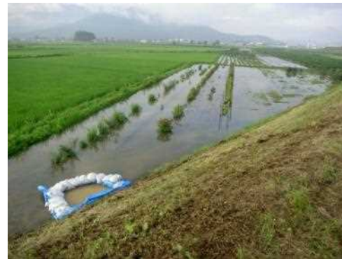
平成18年7月洪水時漏水状況
