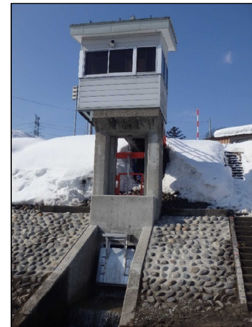
フラップゲート化 完成
