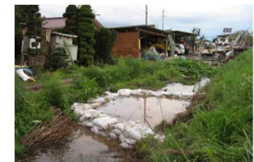
堤防漏水発生状況（右岸）
