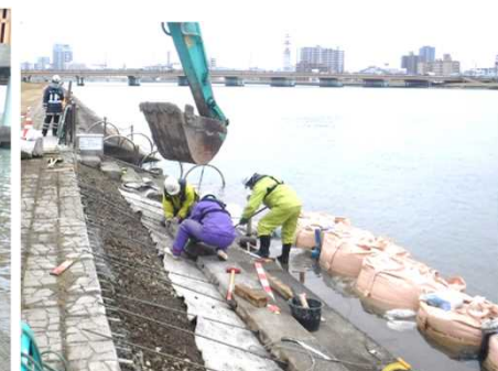
護岸補修作業
