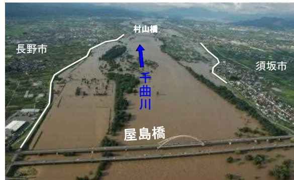
屋島橋上流より
