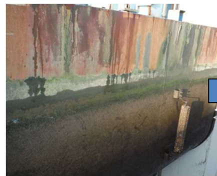
扉体発錆状況(平成29年9月撮影)
