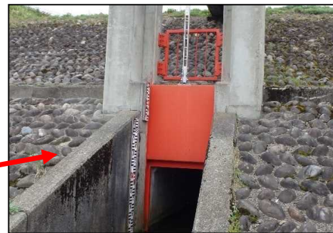
姿樋管扉体（改造前）
