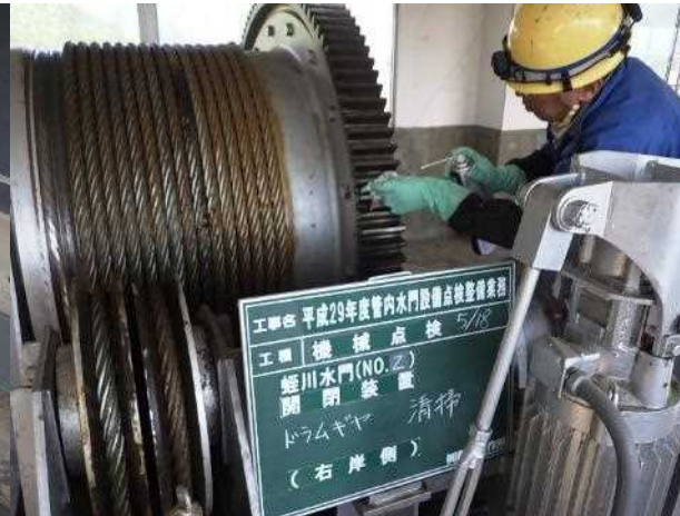
樋門巻上機点検
