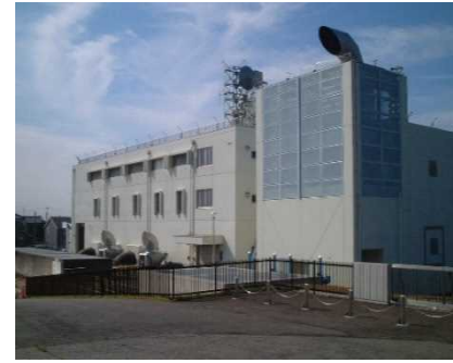
西川排水機場の全景
