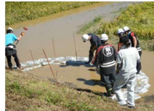
平成25年9月洪水時漏水状況
