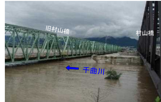
村山橋左岸側より
