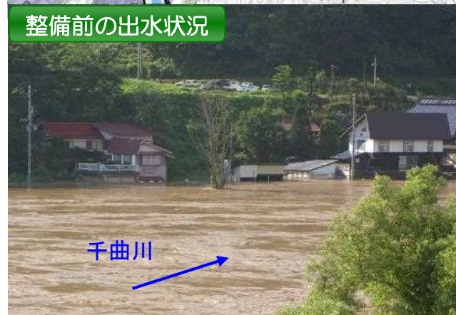
(平成18年7月洪水) 千曲川(L23.8k川面地区)付近で浸水被害が発生
