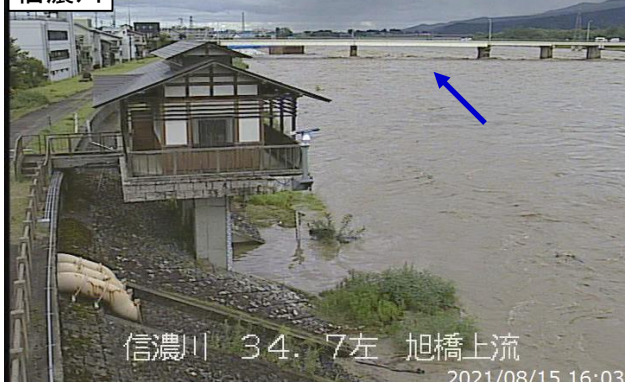
8/15 16:03 信濃川左岸34k7 旭橋上流付近【小千谷市元町】 (氾濫注意水位超過状況)
