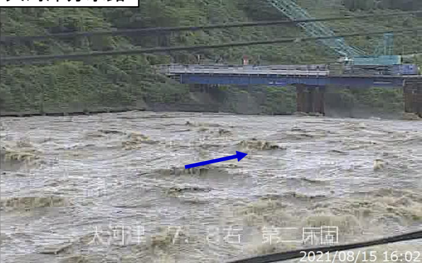
8/15 16:02 大河津分水路右岸7k8 第二床固付近【燕市渡部】 (水防団待機水位超過状況)
