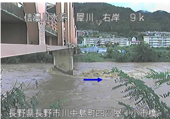
信濃川水系 犀川 右岸 9k 8/15 12:00 犀川右岸9k0 小市橋付近【長野市 川中島町】 (氾濫注意水位超過状況)
