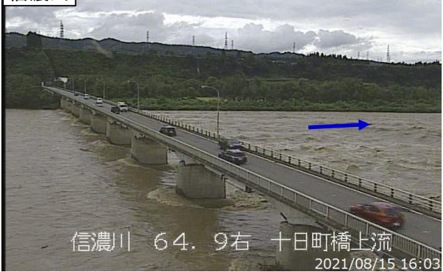
8/15 16:03 信濃川右岸64k9 十日町橋上流付近【十日町市高田町】 (氾濫注意水位超過状況)
