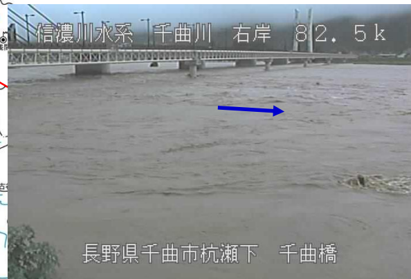
信濃川水系 千曲川 右岸 82.5k 8/15 9:00 千曲川右岸82.5k 千曲橋付近【千曲市杭瀬下】 (氾濫注意水位超過状況)
