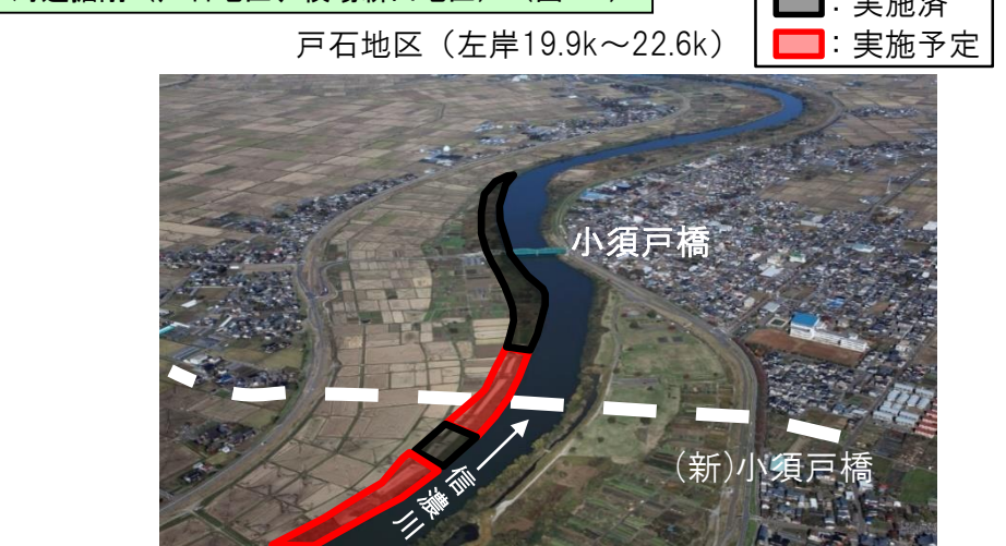
河道掘削 (戸石地区、横場新田地区) (図3-3)
