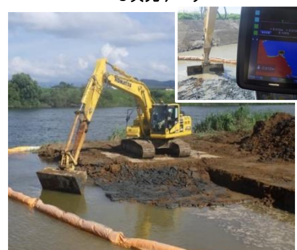
ICT建機による河道掘削
