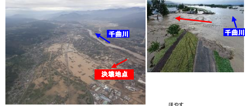
【令和元年(2019年)10月洪水】長野市穂保地先決壊状況
