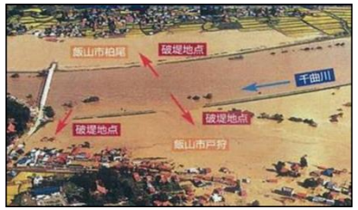
【昭和58年(1983年)9月洪水】飯山市柏尾・戸狩地先本川破堤状況
