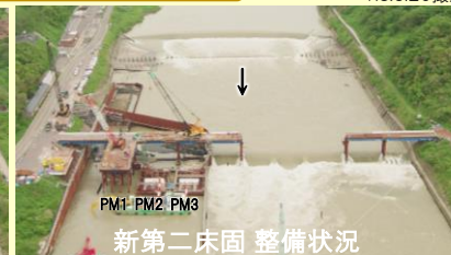
新第二床固 整備状況
