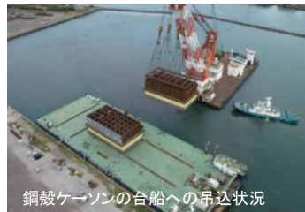
台船への吊込状況 (写真1-3)
