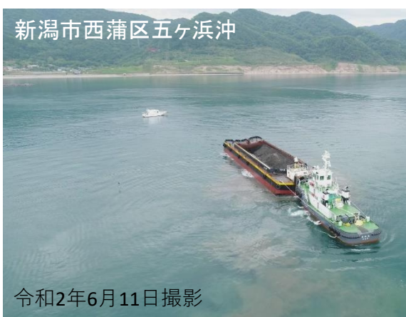
五ヶ浜沖での浚渫土砂投入状況（写真5-2）
