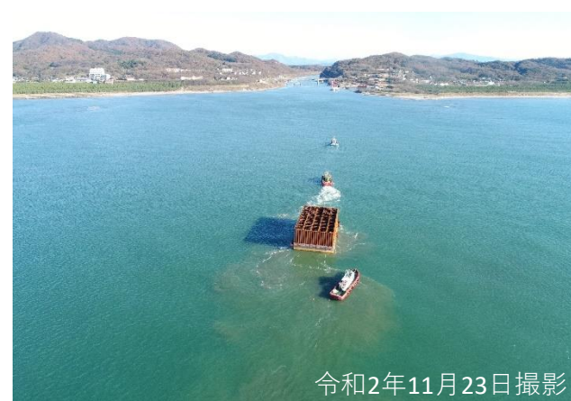
鋼殻ケーソンの海上曳航状況（写真5-3）
