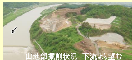
山地部掘削状況 下流より望む
