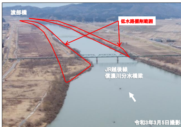
低水路掘削範囲 (写真1-4)
