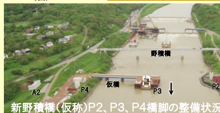
新野積橋(仮称)P2、P3、P4橋脚の整備状況
