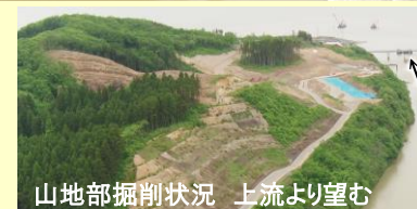
山地部掘削状況 上流より望む
