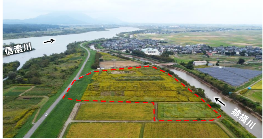
掘削土の有効活用(水防・避難拠点等)(図6-1-2)
