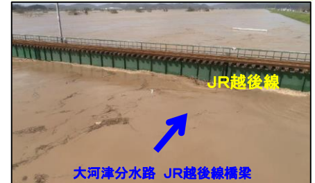
大河津分水路 JR越後線橋
