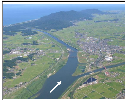
信濃川・大河津分水路を望む
