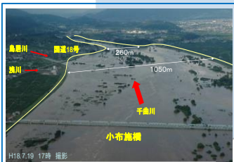
立ヶ花狭窄部掘削
