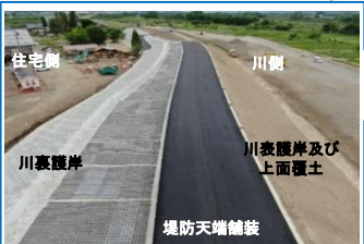
堤防強化(粘り強い河川堤防)
