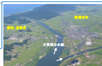
大河津分水路改修事業
