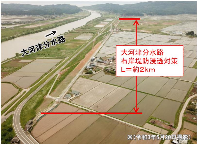
掘削土の有効活用(堤防拡幅)(図6-1-1)
