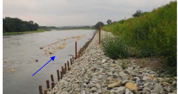
捨石、覆土、木杭による多自然護岸（犀川 9.0k 付近）
