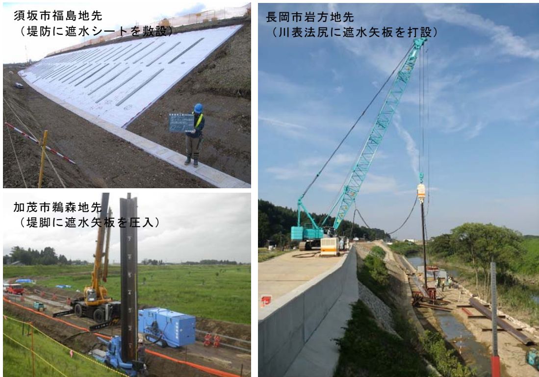
写真 55 浸透対策の実施例
