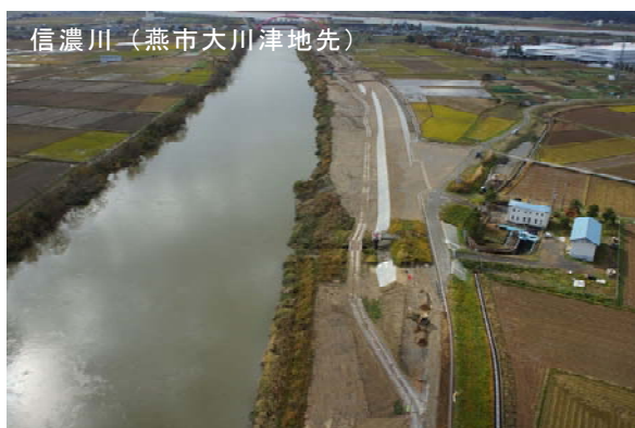
写真 52 堤防整備の実施例
