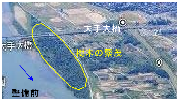
蓮濁地区の左岸寄州に樹木が繁茂
