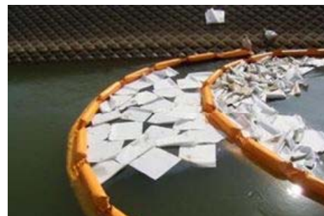
長岡市須川での油除去作業
