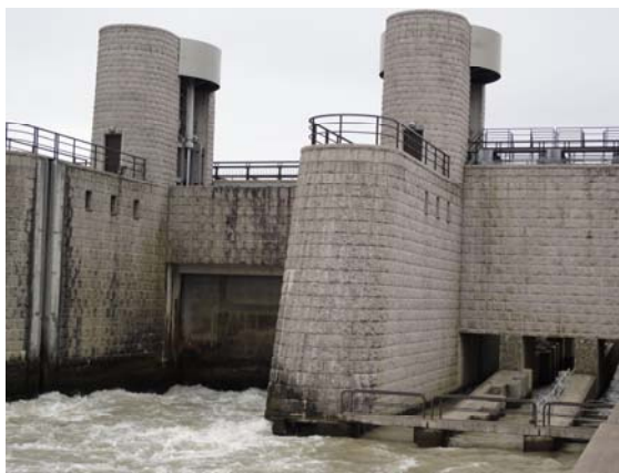
写真 69 大河津分水路における堰の高さを抑えて景観へ配慮した事例
