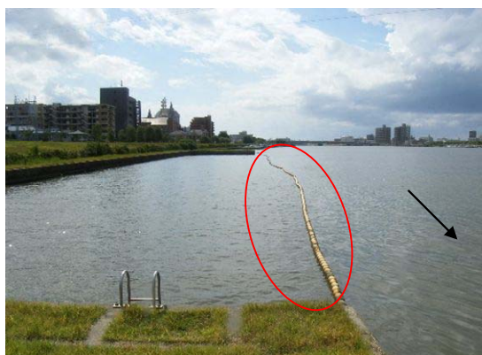
写真 85 不法係留船対策(下流部)
