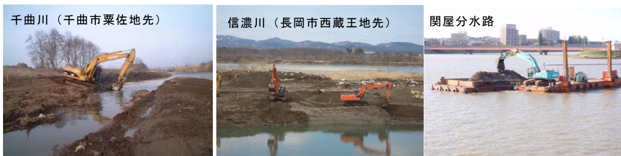
写真 53 河道掘削の実施例
