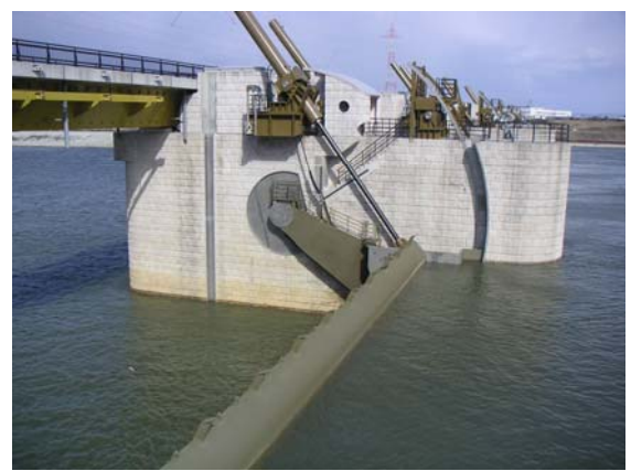
写真 69 大河津分水路における堰の高さを抑えて景観へ配慮した事例
