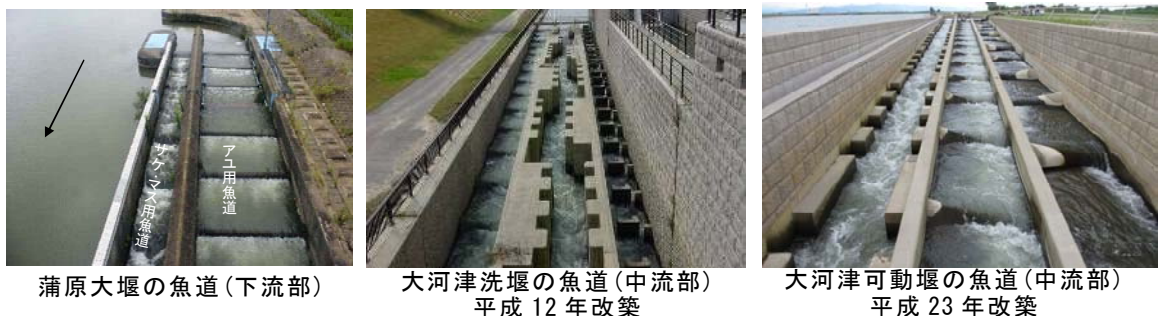
写真 68 魚道の設置事例
