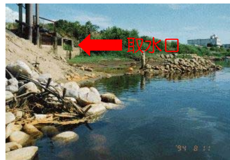
取水口からの取水不能(加茂市)
