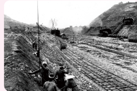
▲大河津分水路開削工事
