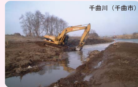
▲河道掘削の実施例
