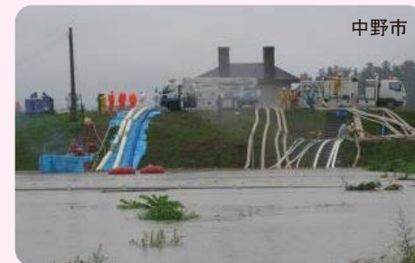
▲宅地側の内水排除の実施状況
