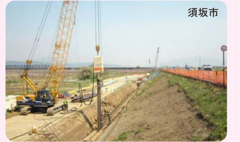
▲漏水対策の実施例
