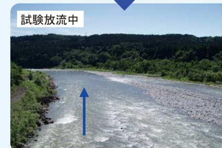
▲宮中取水ダムによる試験放流の実施状況
