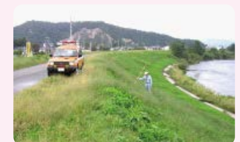
▲河川巡視の状況
