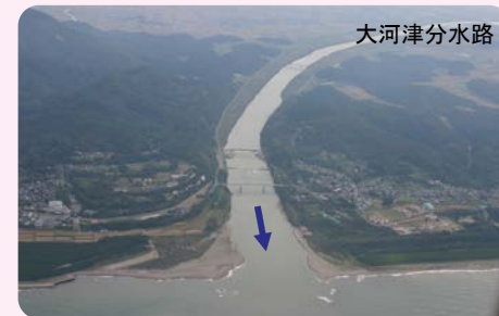
▲大河津分水路の状況
