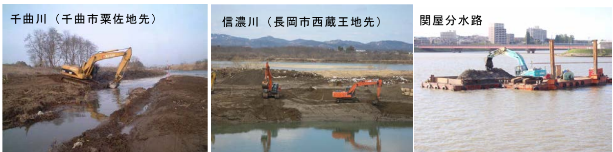
写真 53 河道掘削の実施例
