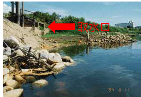
取水口からの取水不能(加茂市)
