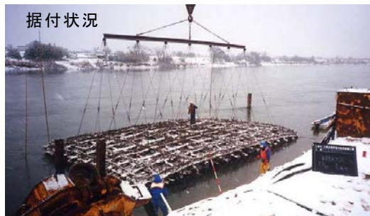
三条市本町地先における粗朶沈床の整備例（平成 21 年）
