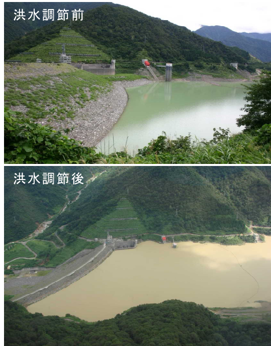
図 16 平成 23 年 7 月洪水時における三国川ダムの洪水調節の様子
