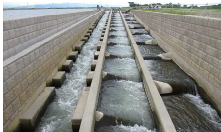
大河津可動堰魚道
