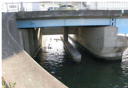
信濃川水門に設置された魚道
