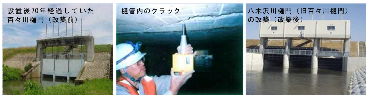
写真 17 八木沢川樋門(千曲川)の改築状況
