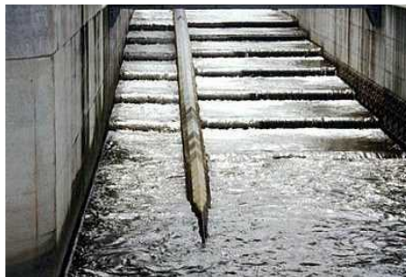
大島頭首工に設置された魚道
