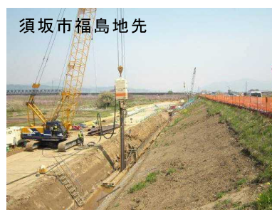
写真 12 漏水対策工事
