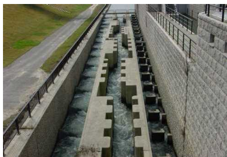
大河津洗堰魚道
