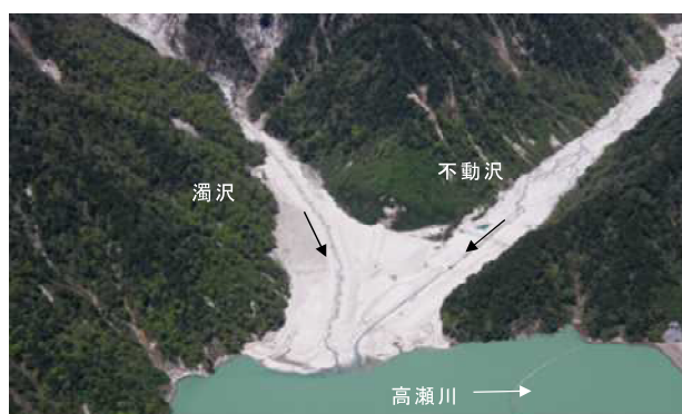
写真 21 高瀬川上流域の堆砂状況
