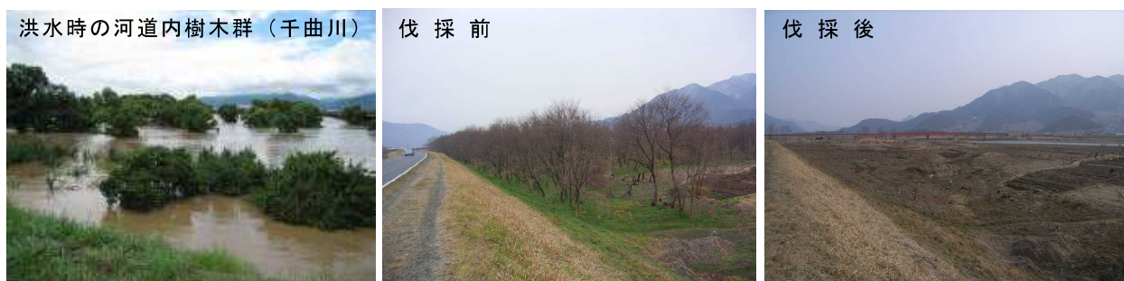
写真 51 樹木伐採の状況（上流部）
