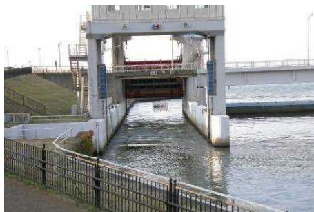
新潟大堰に設置された魚道
