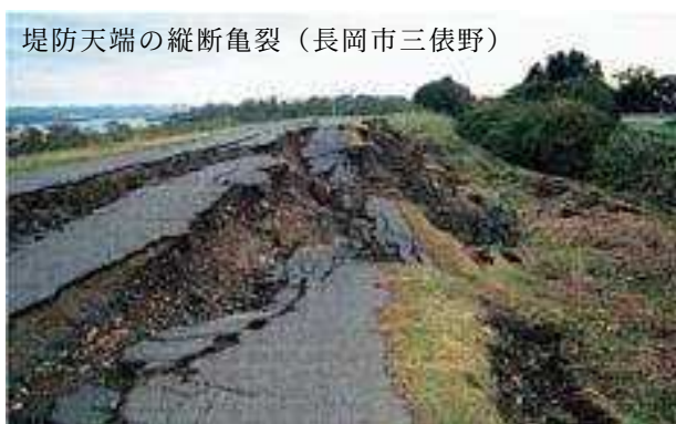
写真 10 新潟県中越地震(左)及び新潟県中越沖地震(右)による堤防の被災状況
