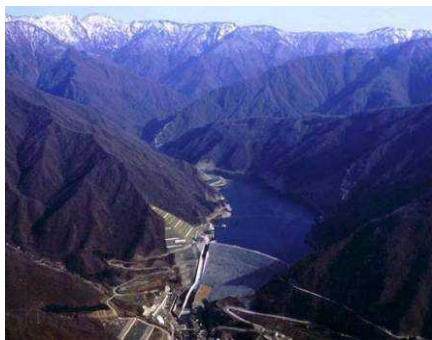
写真 22 三国川ダム (三国川)
