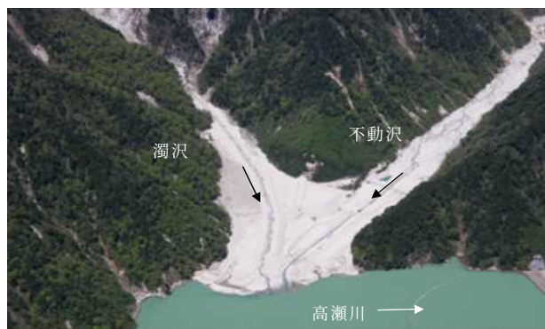
写真 21 高瀬川上流域の堆砂状況
