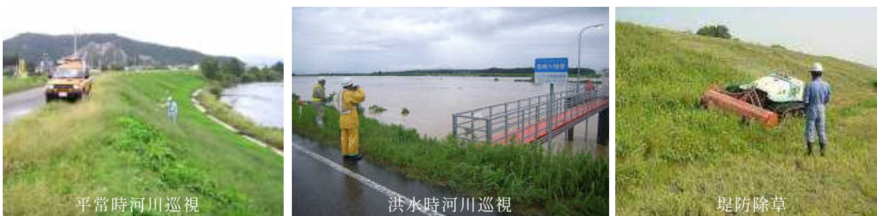
写真 50 河川巡視・堤防除草の状況
