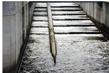
大島頭首工に設置された魚道
