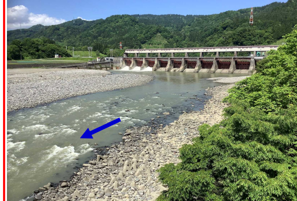
写真 24 宮中取水ダムの放流による減水区間の改善状況
