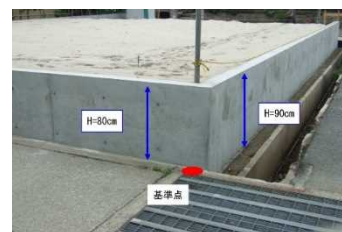
図 54 宅地かさ上げ状況
