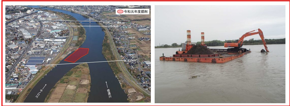
写真 69 維持掘削の実施状況 (信濃川中ノ口川合流点付近)
