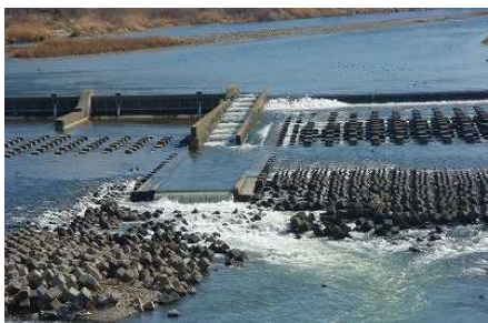
埴科用水頭首工（千曲川）の魚道
