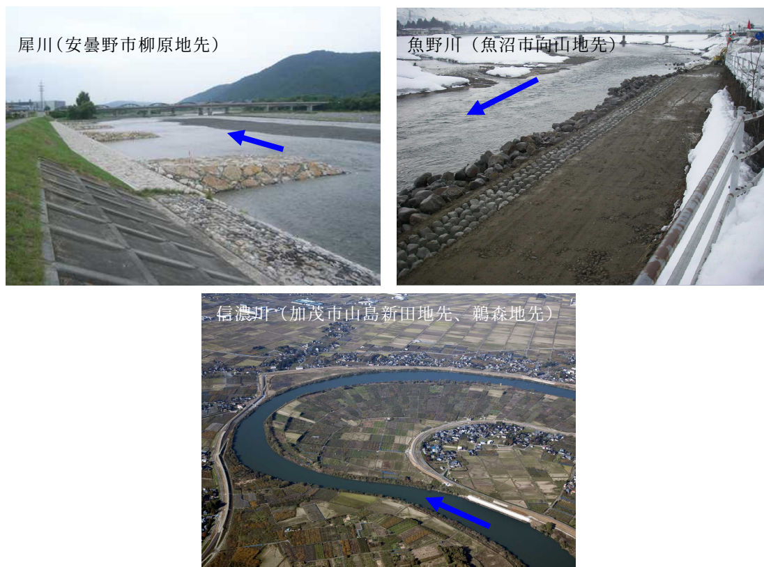
写真 56 水衝部対策の実施例
