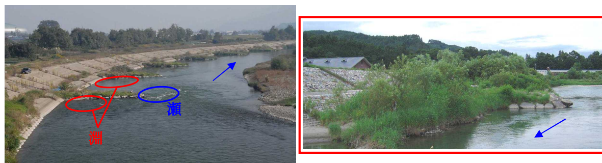
石出しによる不透過水制の設置による 瀬・淵の創出（千曲川 70.1k 付近）
