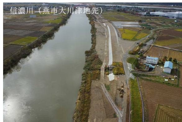
写真 53 堤防整備の実施例
