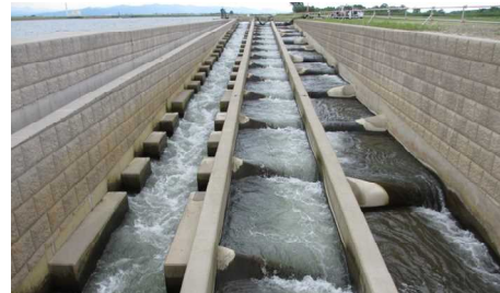
大河津可動堰魚道
