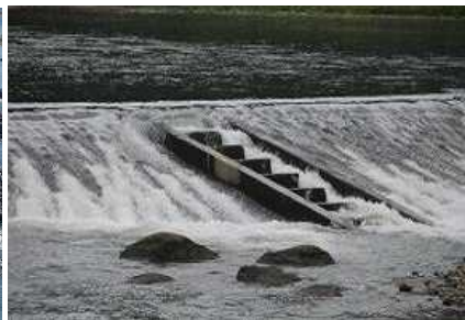
上田農水頭首工（千曲川）の魚道
