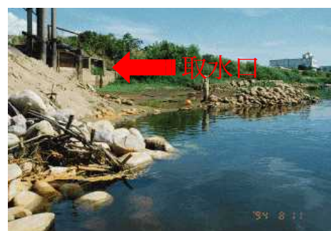
取水口からの取水不能(加茂市)
