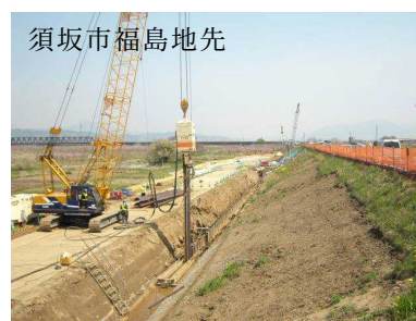
写真 12 漏水対策工事
