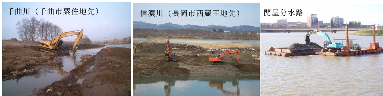
写真 54 河道掘削の実施例
