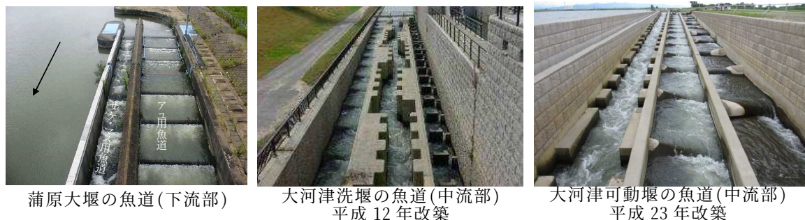
写真 65 魚道の設置事例
