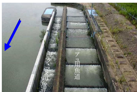
蒲原大堰に設置された魚道
