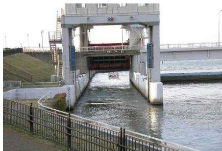
新潟大堰に設置された魚道
