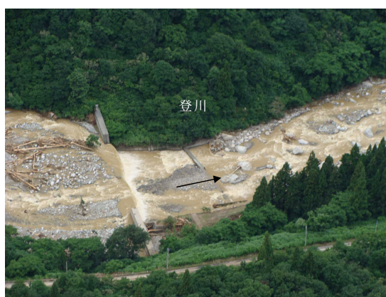
写真 20 梓川、魚野川上流域の荒廃状況、砂防堰堤の堆砂状況
