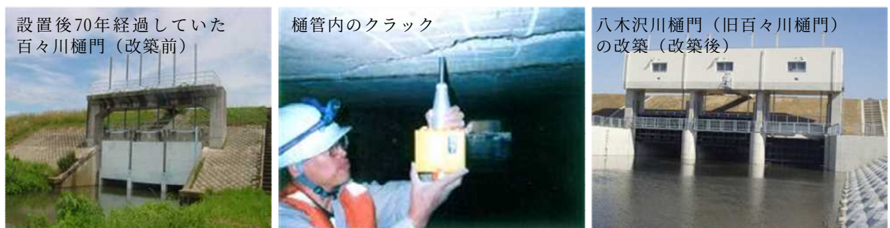
写真 17 八木沢川樋門 (千曲川) の改築状況
