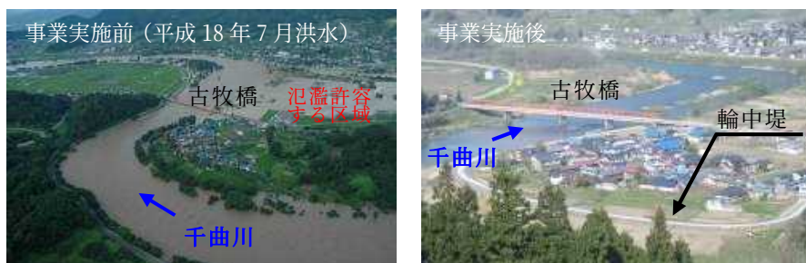
写真 5 土地利用一体型水防災事業で輪中堤を整備した中野市古牧地区（千曲川）
