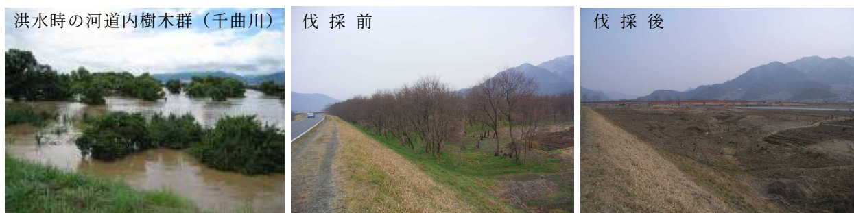
写真 51 樹木伐採の状況（上流部）
