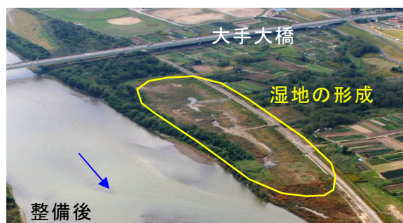
樹木伐採と地盤の切下げにより湿地を形成
