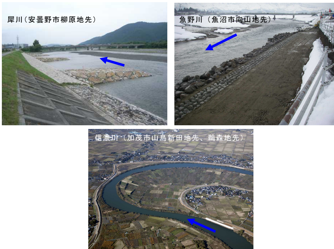
写真 57 水衝部対策の実施例
