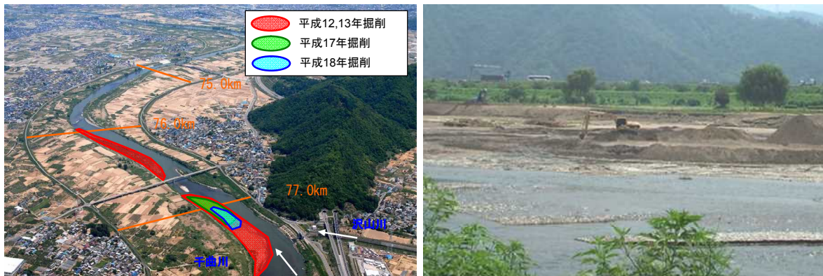
写真 69 維持掘削の実施状況(千曲川沢山川合流点付近)
