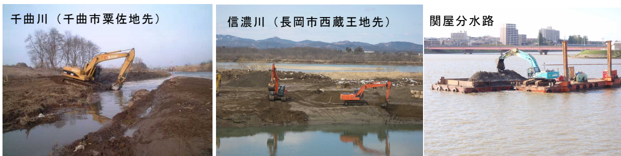
写真 55 河道掘削の実施例
