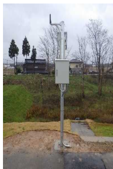
危機管理型水位計設置例
