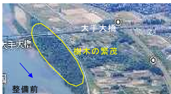
蓮濁地区の左岸寄州に樹木が繁茂
