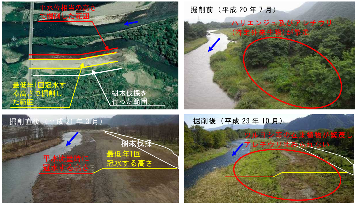
写真 61 多自然川づくりの事例(千曲川・鼠地区での試験掘削)
