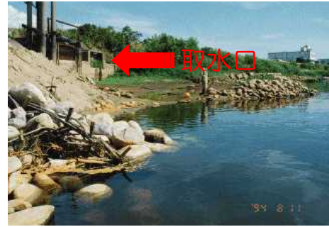
取水口からの取水不能（加茂市）
