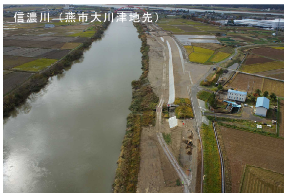
写真 54 堤防整備の実施例
