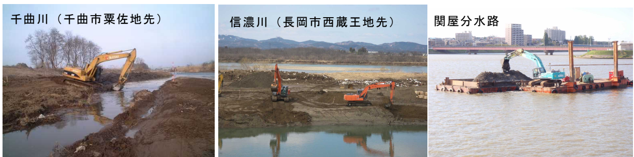
写真 55 河道掘削の実施例
