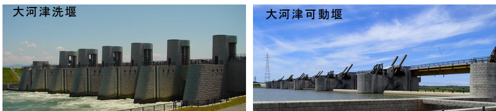
写真 67 大河津分水路における堰の高さを抑えて景観へ配慮した事例
