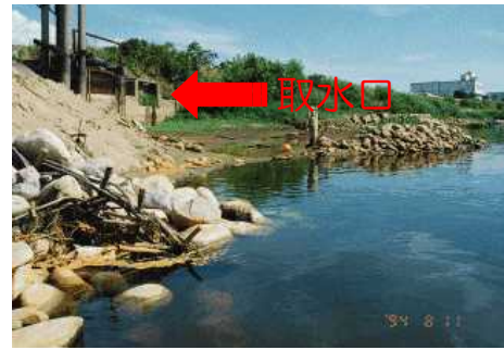
取水口からの取水不能（加茂市）
