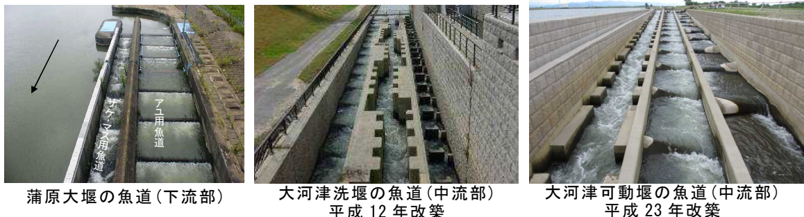
写真 66 魚道の設置事例
