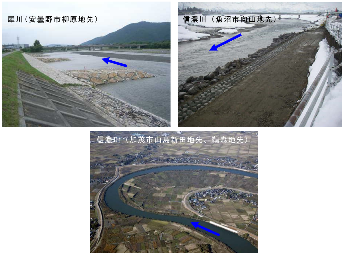
写真 55 水衝部対策の実施例
