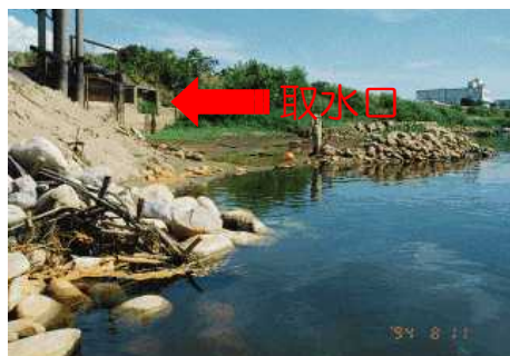
取水口からの取水不能(加茂市)
