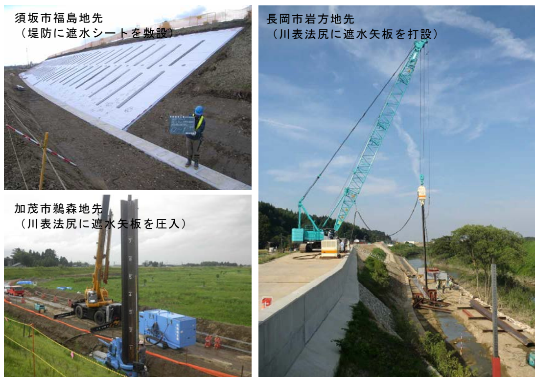
写真 54 浸透対策の実施例
