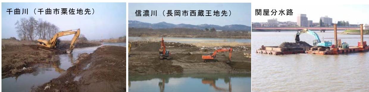
写真 53 河道掘削の実施例
