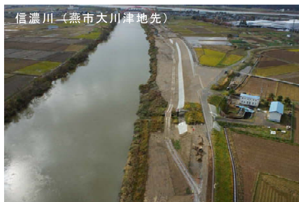
写真 52 堤防整備の実施例
