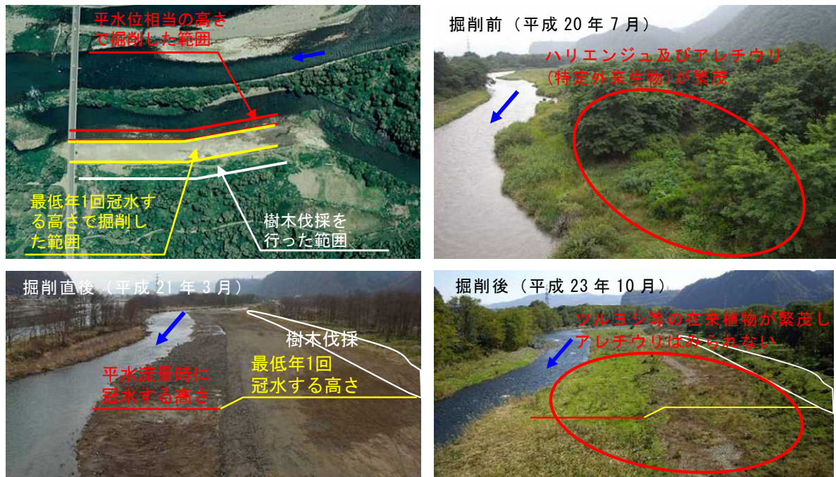
写真 62 多自然川づくりの事例(千曲川・鼠地区での試験掘削)
