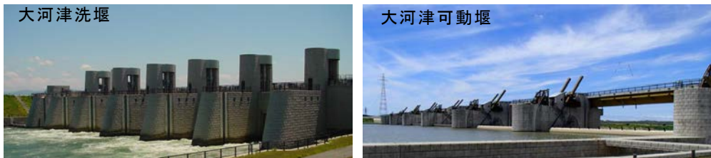
写真 68 大河津分水路における堰の高さを抑えて景観へ配慮した事例
