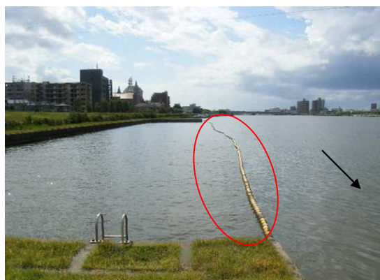
写真 84 不法係留船対策(下流部)
