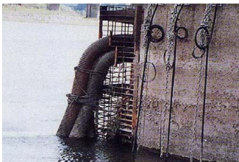
仮設ポンプで取水する小千谷市 水道・工業用水
