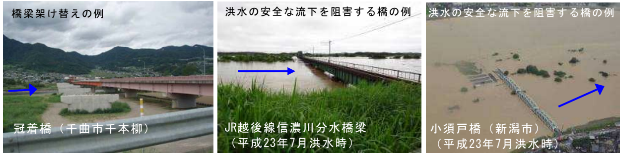
写真 8 改築が必要な横断工作物の例
