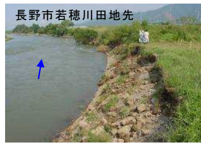
長野市若穂川田地先 平成16年10月洪水による河岸の侵食 写真13
