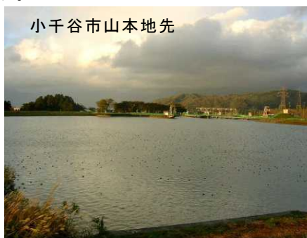
写真 22 山本調整池(JR 東日本、信濃川)
