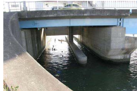
信濃川水門に設置された魚道
