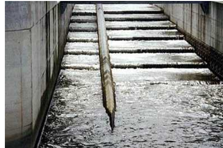
大島頭首工に設置された魚道
