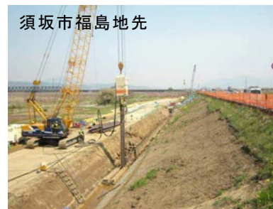
写真 12 漏水対策工事
