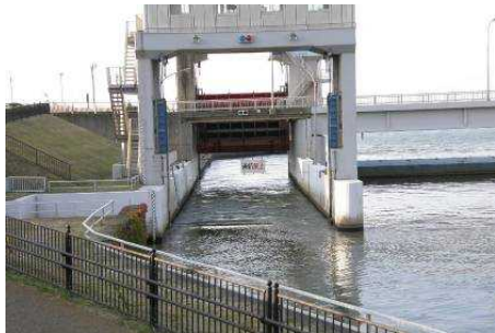
新潟大堰に設置された魚道
