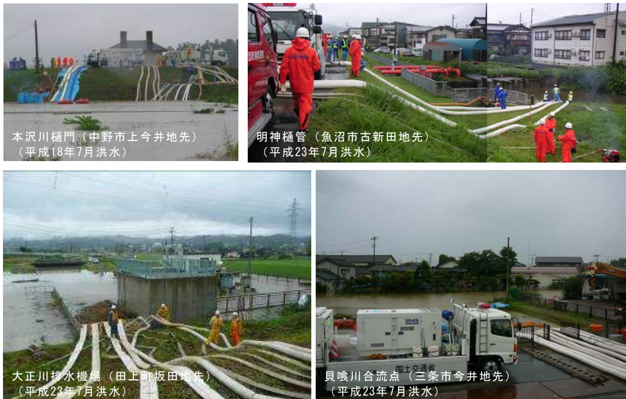
写真 9 内水被害発生と対策の実施状況
