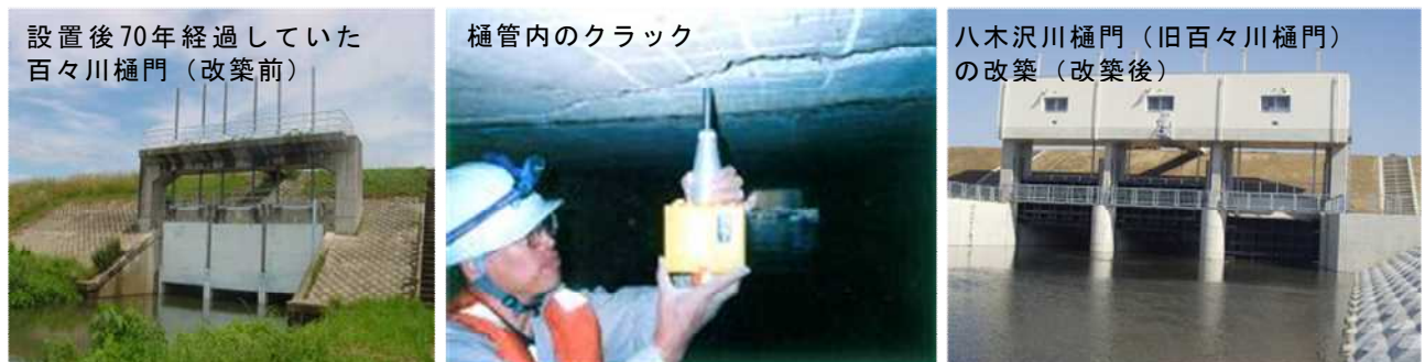
写真 19 八木沢川樋門(千曲川)の改築状況
