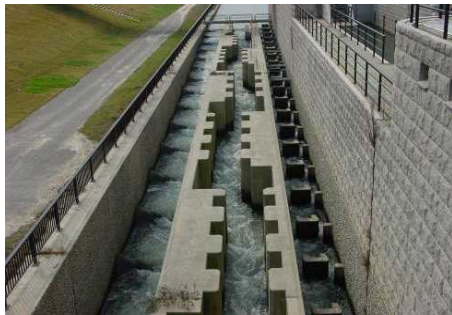
大河津洗堰魚道
