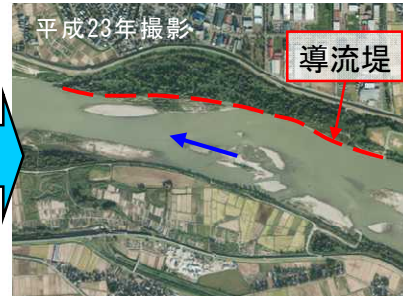
導流堤の施工により低水路が安定
