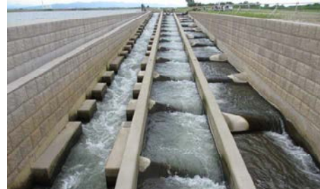
大河津可動堰魚道
