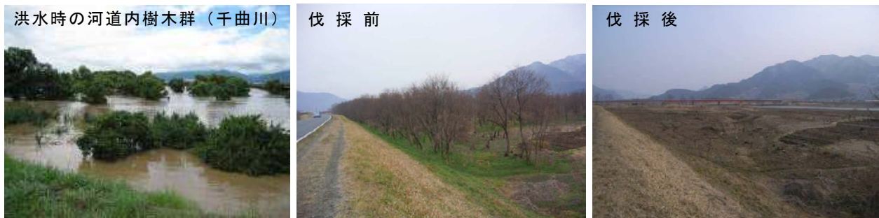
写真 50 樹木伐採の状況(上流部)
