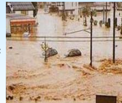
刈谷田川の破堤状況
