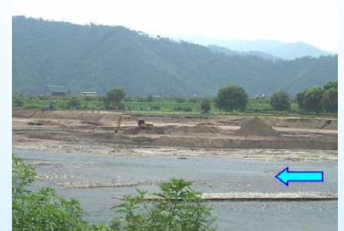
千曲川（岩野地区）河道掘削
