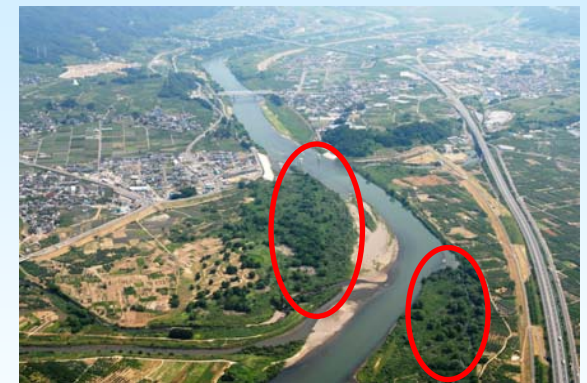
千曲川5.3km（立ヶ花橋上流）付近の樹木群繁茂状況
