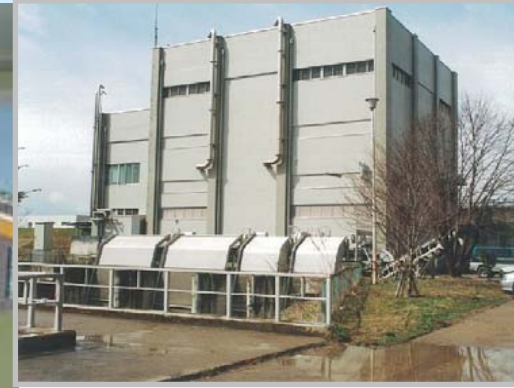
篠井川排水機場(上流部)
