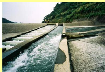
第二床固魚道
