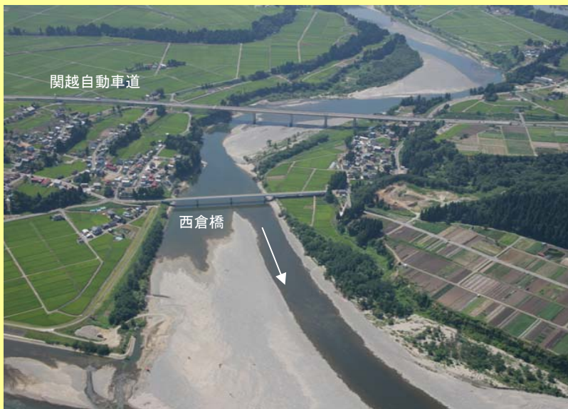
関越自動車道橋梁付近
