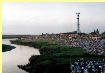
長岡市街地の緩傾斜堤防
