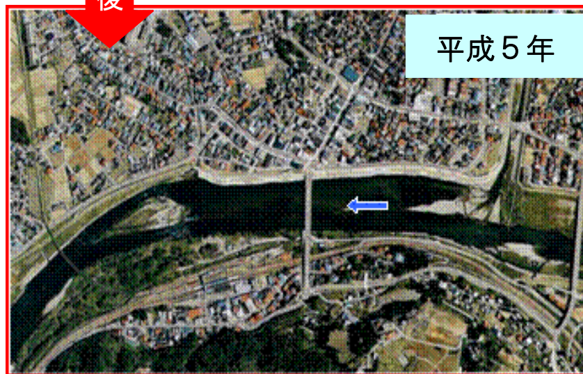
小出地区改修前後の状況
