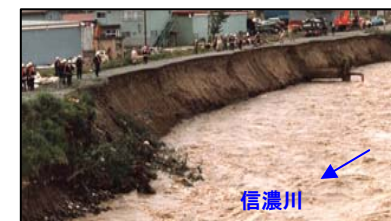
十日町高島地先での堤防欠壊状況
