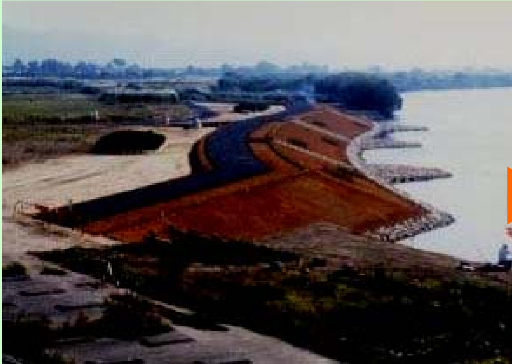
【施工中(平成4年)】
