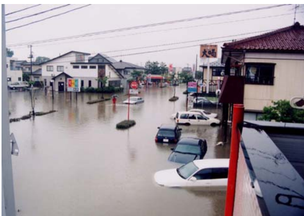
大堀幹線の冠水状況
