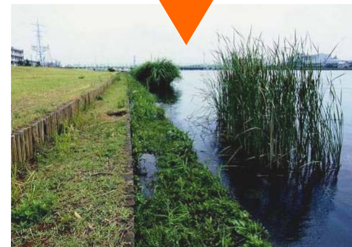
【施工後(平成16年)】
