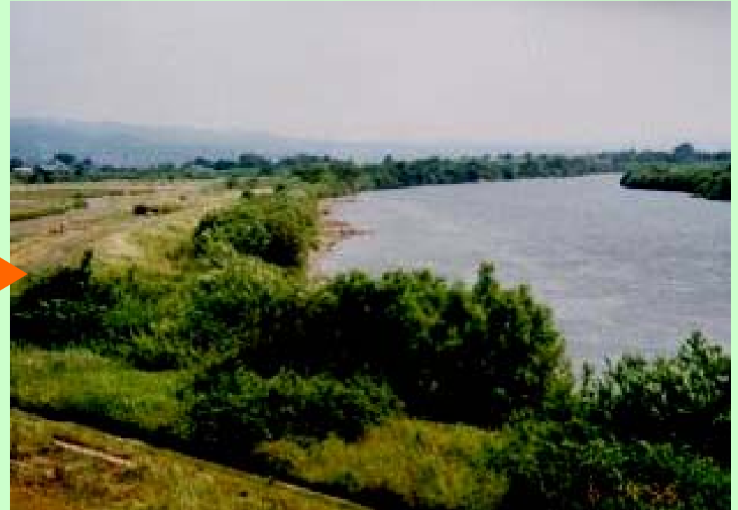
【施工後(平成11年)】
