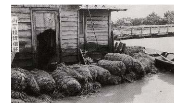
米俵による土嚢積み
