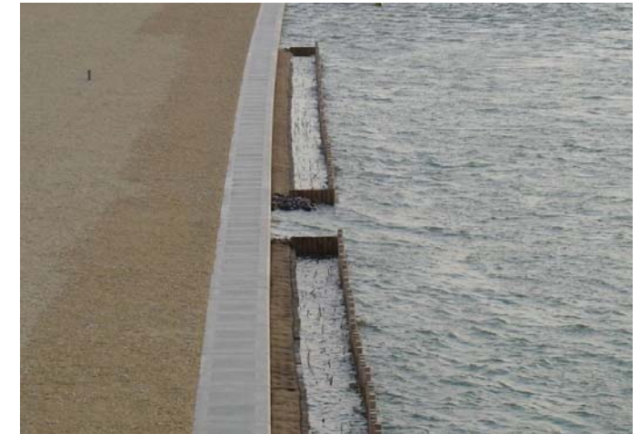
【施工直後(平成15年)】
