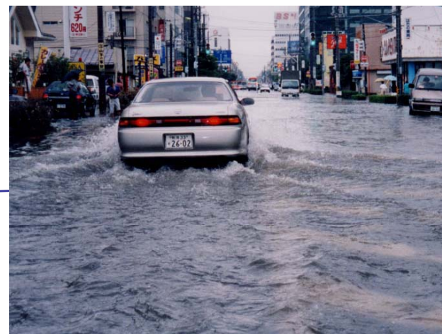
笹出線の冠水状況
