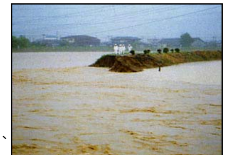
破堤した五十嵐川
