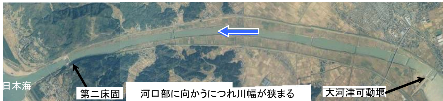
大河津分水路改修
