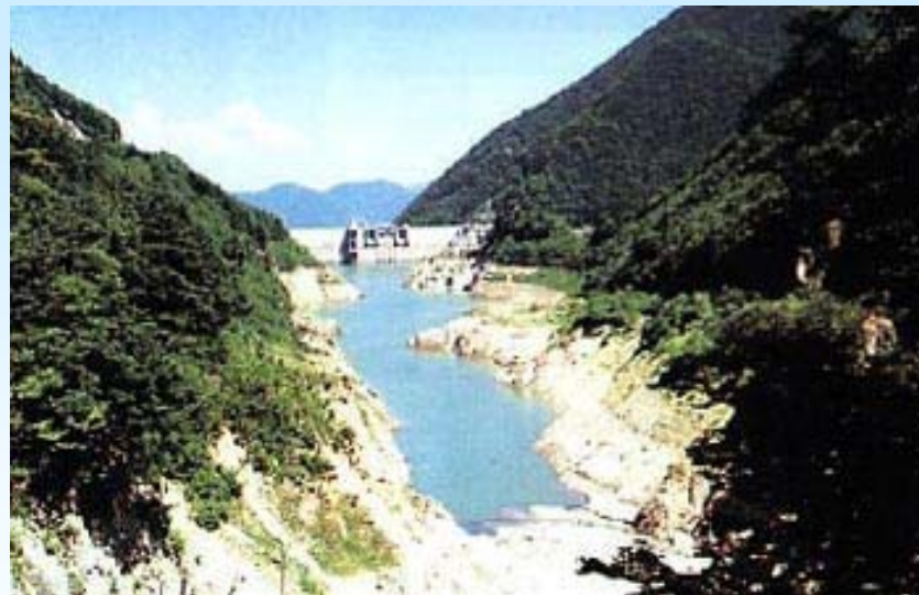
水位低下が著しい大町ダム (H6. 8)
