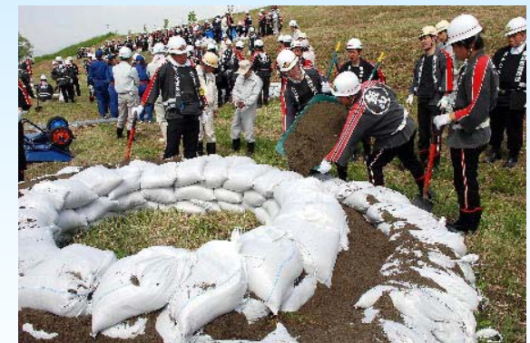
水防訓練 (飯山市・上流部)
