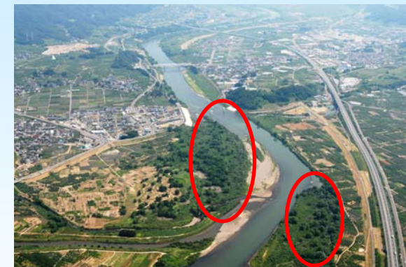
千曲川5.3km（立ヶ花橋上流）付近の樹木群繁茂状況
