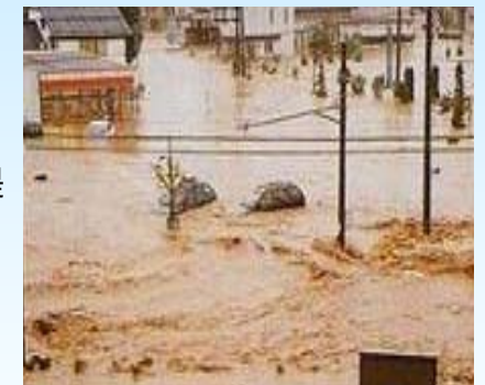
刈谷田川の破堤状況
