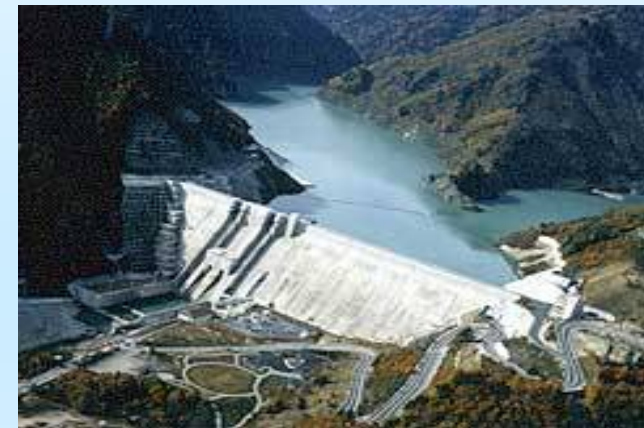
長野市水道の水源の1つである大町ダム
