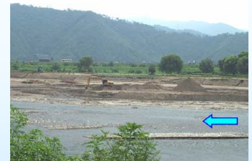
千曲川（岩野地区）河道掘削
