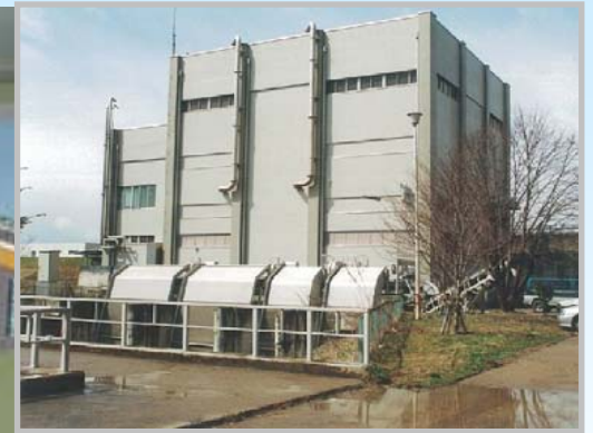
篠井川排水機場(上流部)
