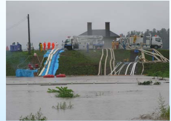
排水ポンプ車による内水対応
