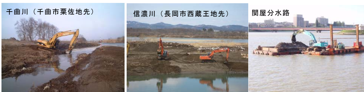
写真 35 河道掘削の実施例
