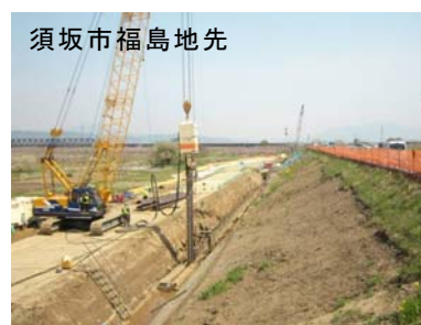
写真 10 漏水対策工事
