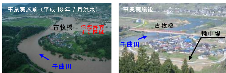
写真 3 土地利用一体型水防災事業で輪中堤を整備した中野市古牧地区(千曲川)
