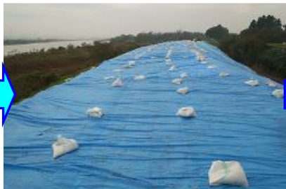
緊急復旧完了 （平成16年10月25日）
