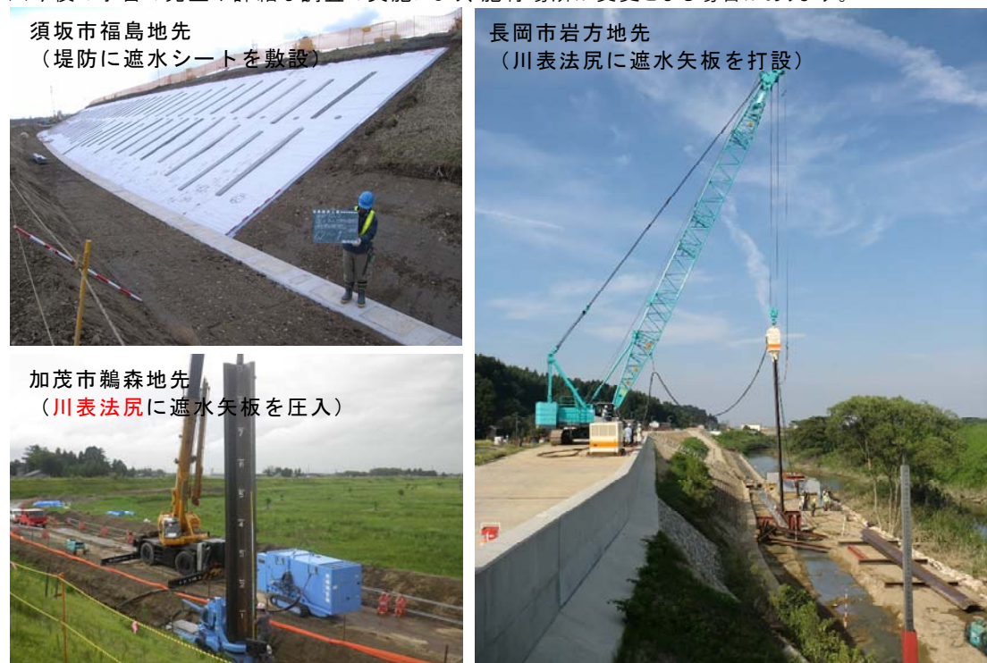
写真 36 浸透対策の実施例
