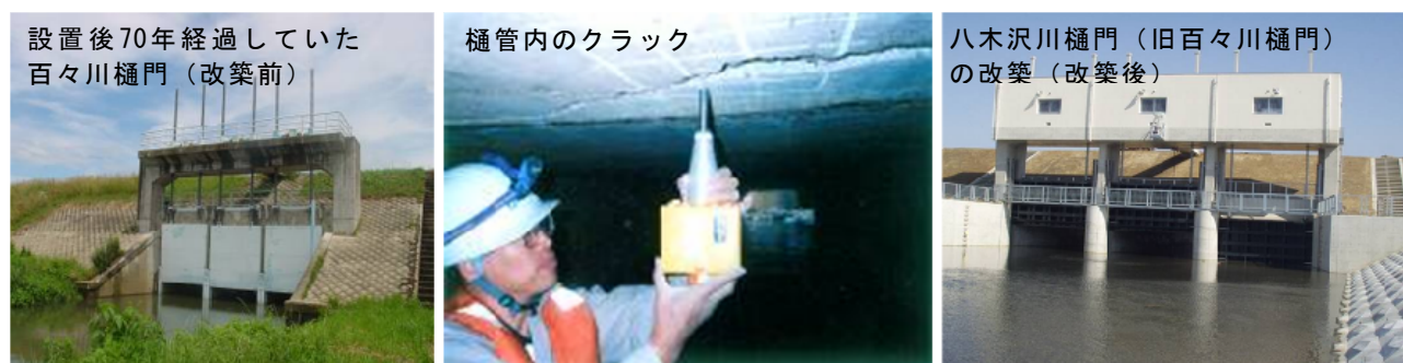
写真 17 八木沢川樋門(千曲川)の改築状況
