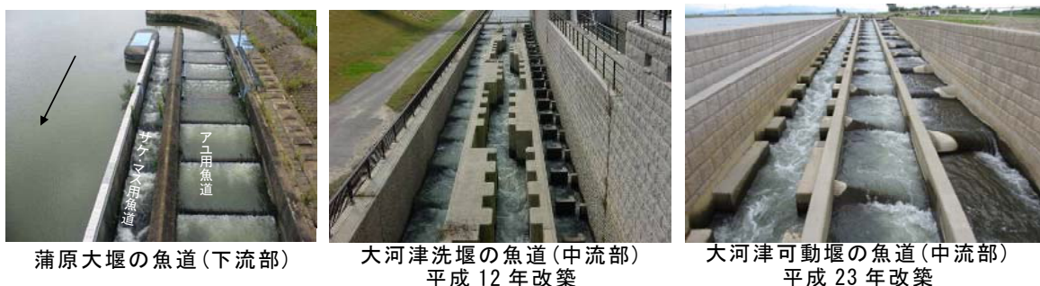
写真 46 魚道の設置事例
