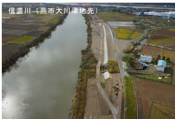
写真 34 堤防整備の実施例
