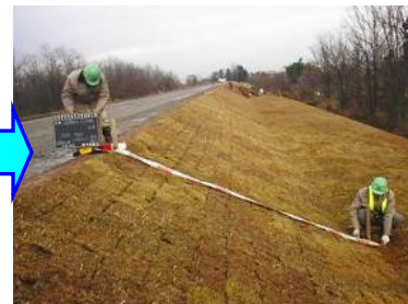
本復旧後の状況
