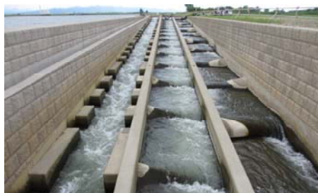
大河津可動堰魚道
