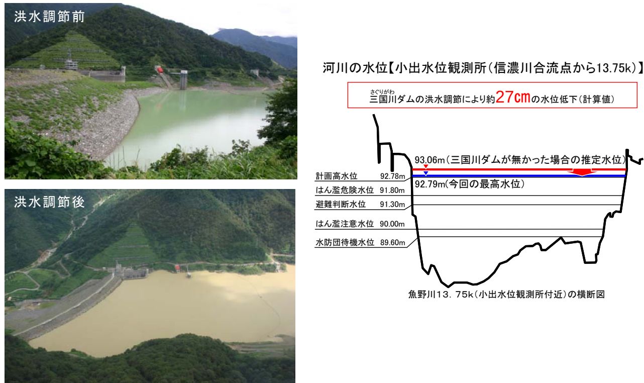
図 10 平成23年7月洪水時における三国川ダムの洪水調節の様子
