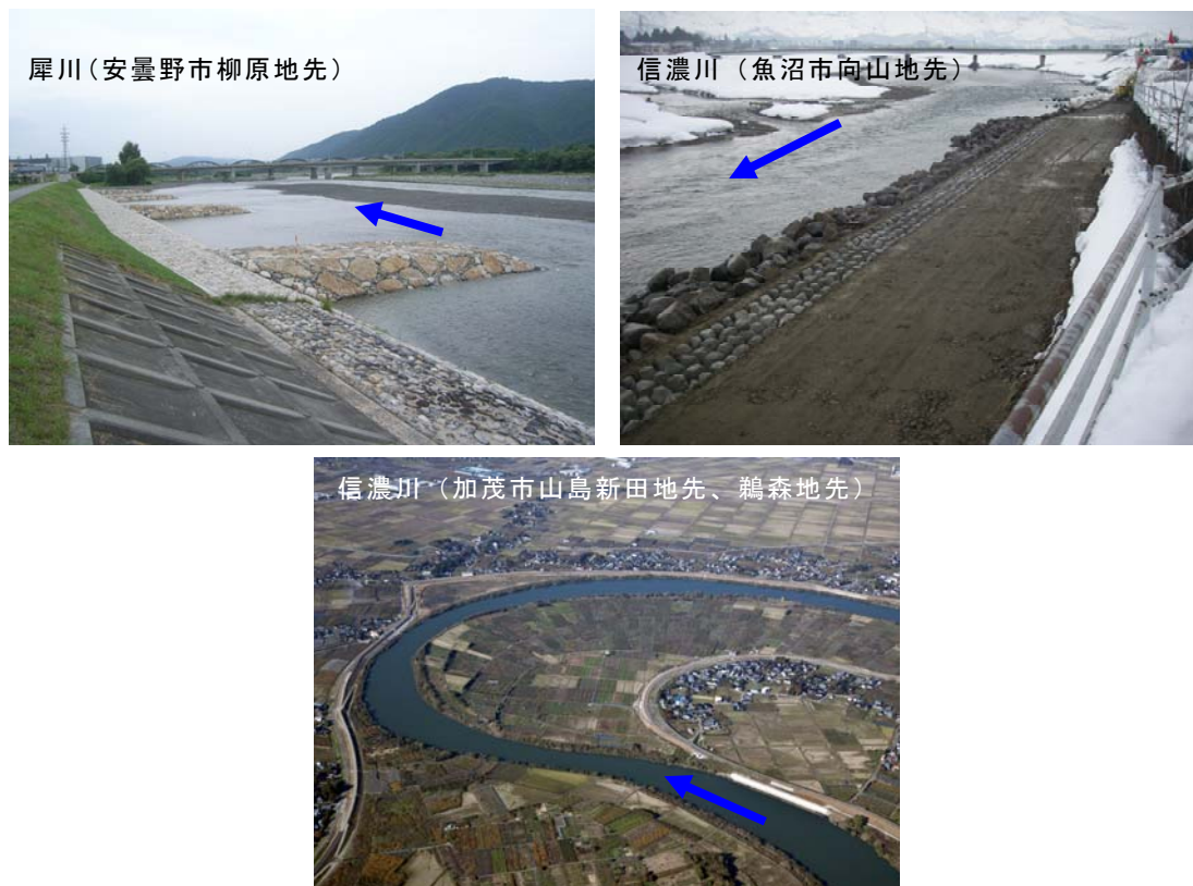
写真 37 水衝部対策の実施例
