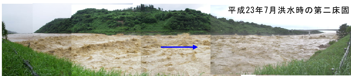
写真2 大河津分水路全体図と洪水時の様子
