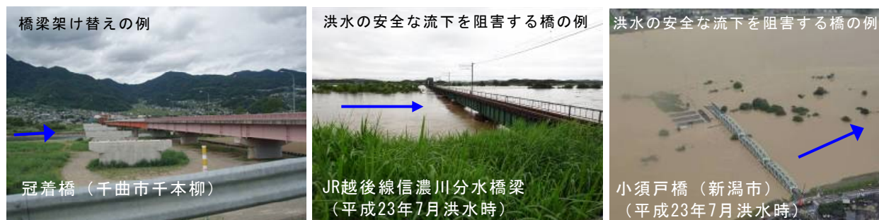
写真 6 改築が必要な横断工作物の例
