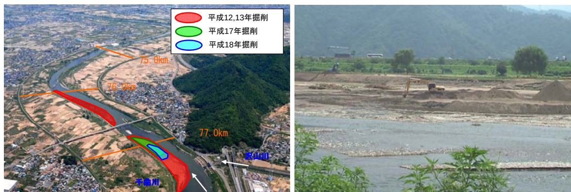
写真 49 維持掘削の実施状況（千曲川沢山川合流点付近）
