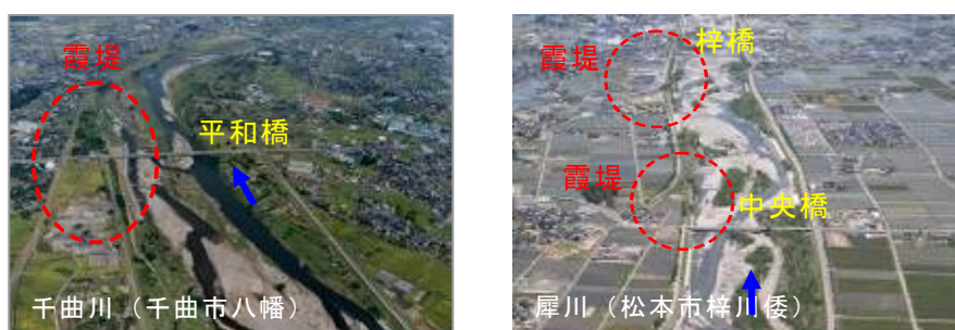
写真 4 千曲川・犀川の霞堤信濃川・魚野川の霞堤
