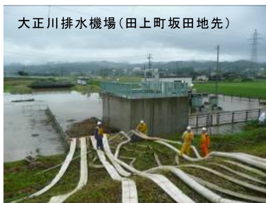
写真 8 内水対策の実施状況(平成 23 年 7 月洪水)
