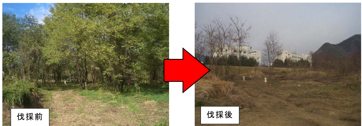
図 42 樹木管理の事例(千曲川 坂城町上五明地先)
