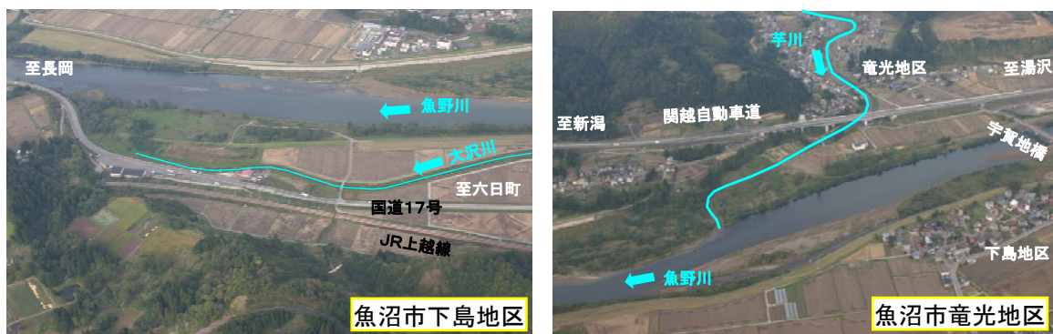
写真 15 支川合流点処理が必要な大沢川、芋川(魚沼市下島地区、魚沼市竜光地区)
