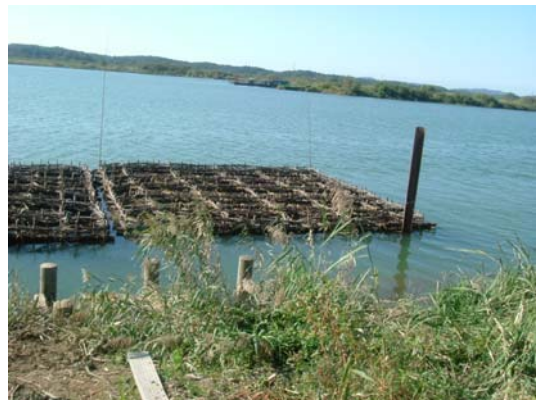
長岡市真代地先 (粗朶沈床)
