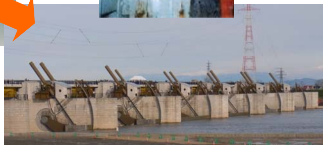
図 22 大河津可動堰の改築状況
