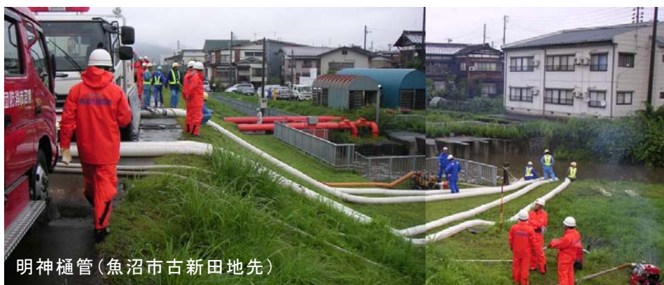
写真 7 内水対策の実施状況(平成 23 年 7 月洪水)
