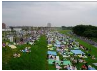
長岡市街地の緩傾斜 堤防：蓮潟地区
