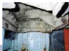
腐食している架台
