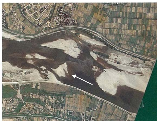
導流堤施工前(昭和 53 年撮影)
