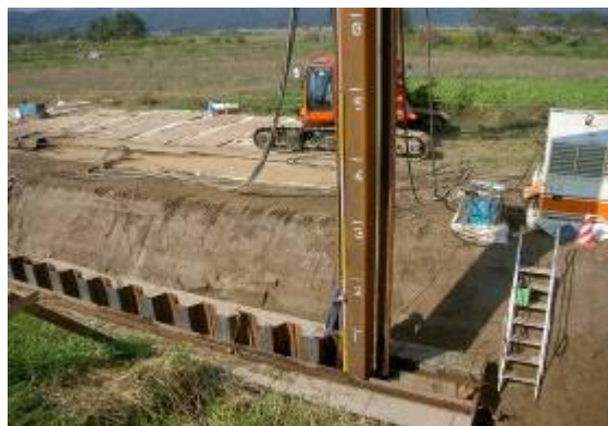
写真 12 漏水対策工事
