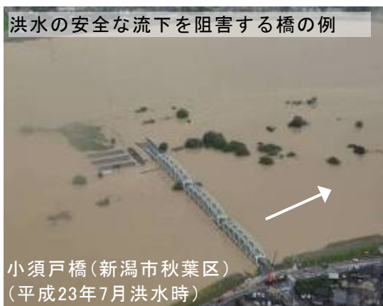
写真 5 改築が必要な横断工作物の例
