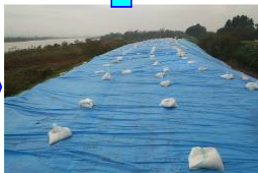
緊急復旧完了 (平成 16 年 10 月 25 日)
