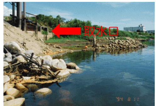
取水口からの取水不能（加茂市）
