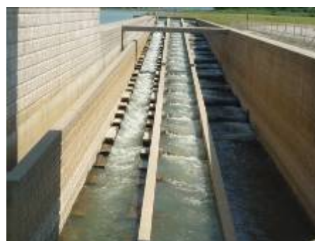
大河津可動堰の新たな左岸魚道
