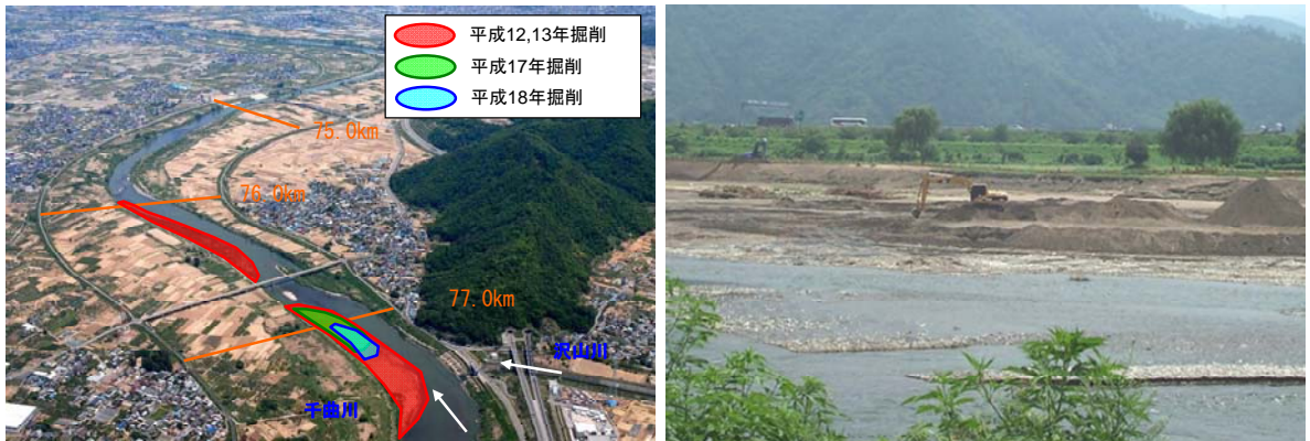
図 41 維持掘削の実施状況(千曲川沢山川合流点付近)
