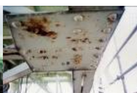
腐食している架台
