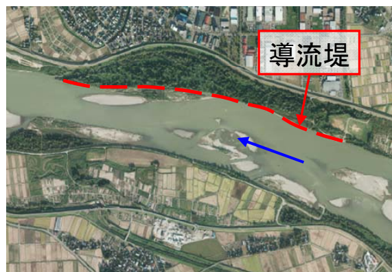
導流堤の施工により低水路が安定(平成 23 年撮影)
