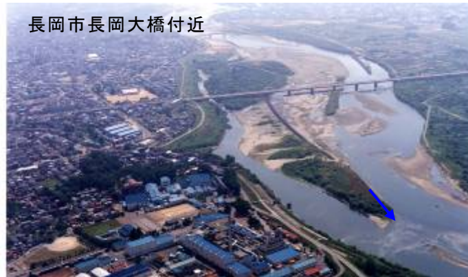
写真 18 渇水の状況(平成6年)
