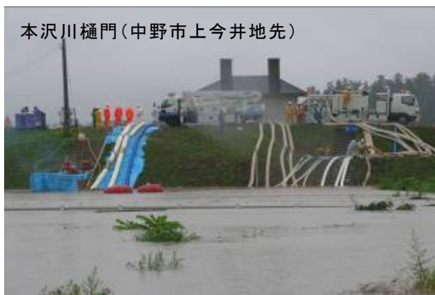
写真 6 内水対策の実施状況(平成 18 年 7 月洪水)
