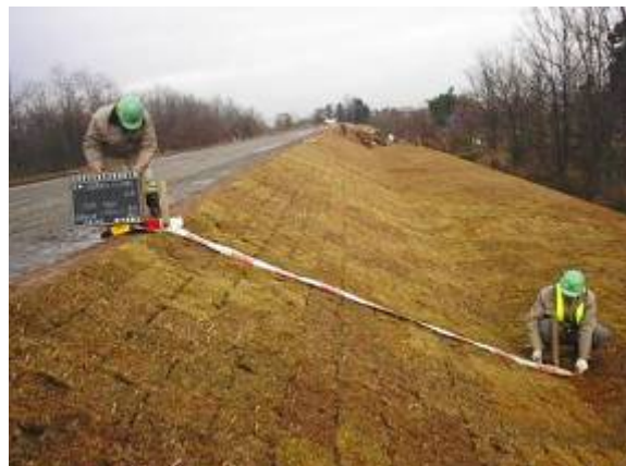
本復旧後の状況
