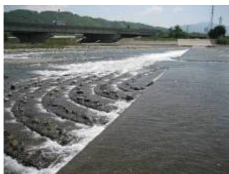
勘左衛門堰 かんざえもん の改良された魚道（犀川）
