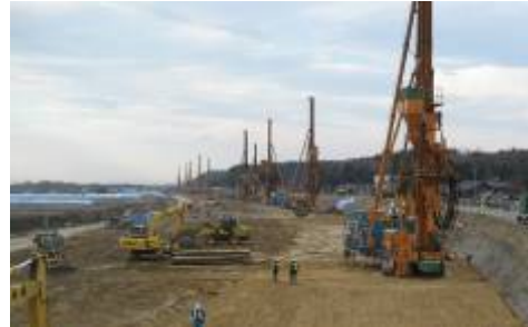
耐震対策の実施状況 (長岡市町軽井)
