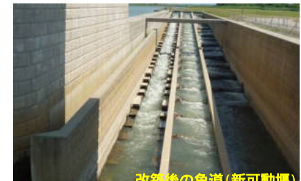
改築後の魚道(新可動堰)
