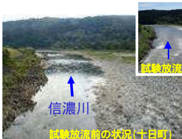
試験放流前の状況(十日町)
