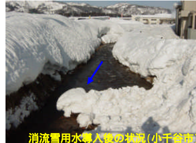
消流雪用水導入後の状況(小千谷市)
