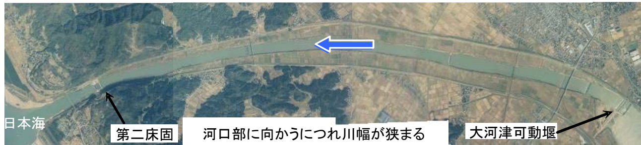
大河津分水路改修
