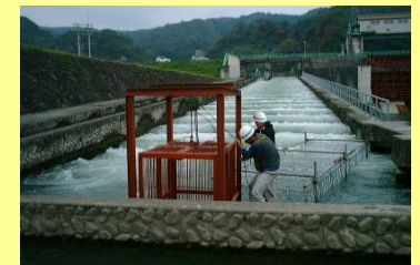
宮中取水ダム魚道
