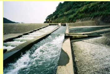
第二床固魚道
