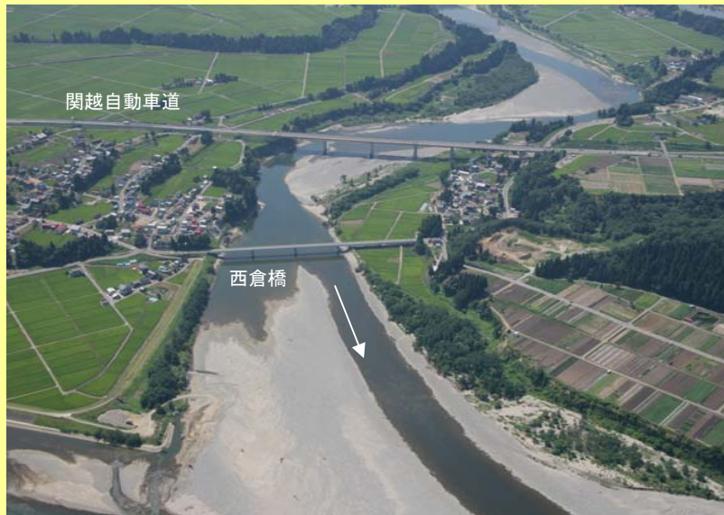
関越自動車道橋梁付近
