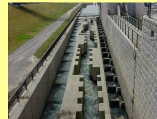
大河津洗堰魚道
