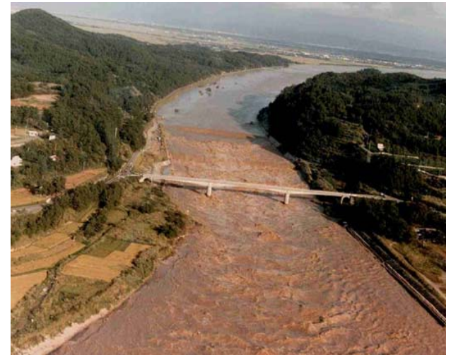
晴天の中、洪水を放流する大河津分水路
