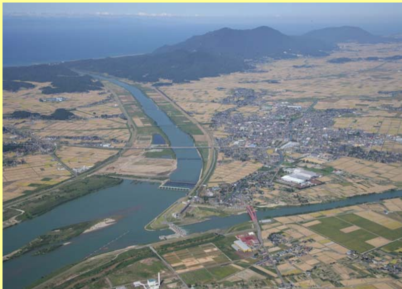
大河津分水路付近
