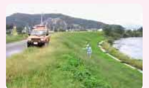
▲河川巡視の状況
