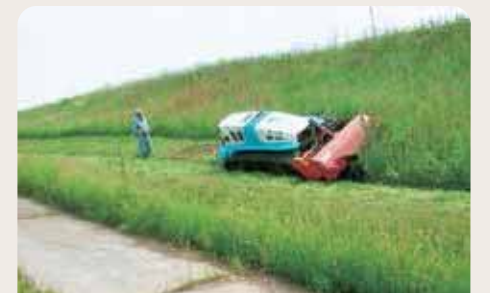
▲堤防除草の状況
