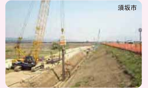
▲漏水対策の実施例
