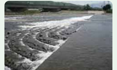
▲勘左衛門堰（犀川）の魚道
