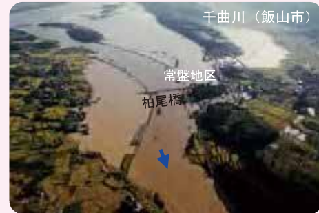
▲千曲川堤防の破堤(昭和58年9月)
