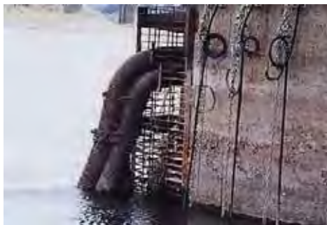
仮設ポンプで取水する小千谷市 水道・工業用水
