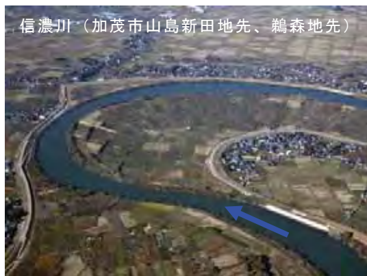
写真 56 水衝部対策の実施例
