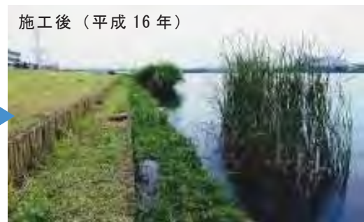
新潟市上所地区における矢板前面への植栽 (マコモ) 整備例
