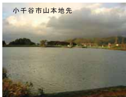
写真 22 山本調整池(JR 東日本、信濃川)
