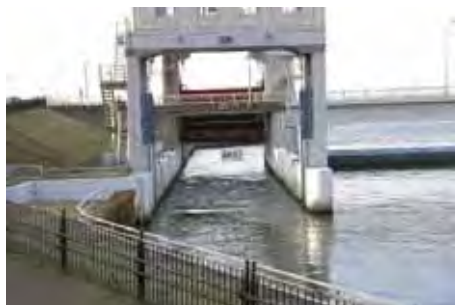
新潟大堰に設置された魚道
