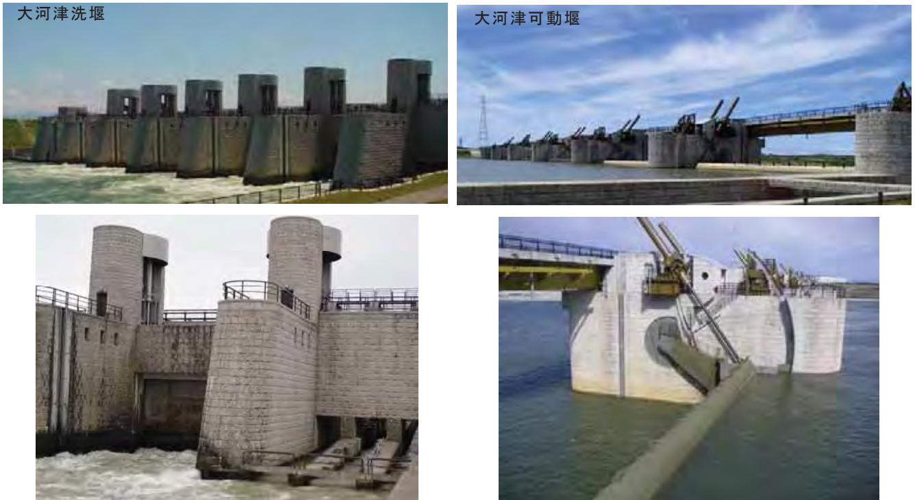
写真 69 大河津分水路における堰の高さを抑えて景観へ配慮した事例
