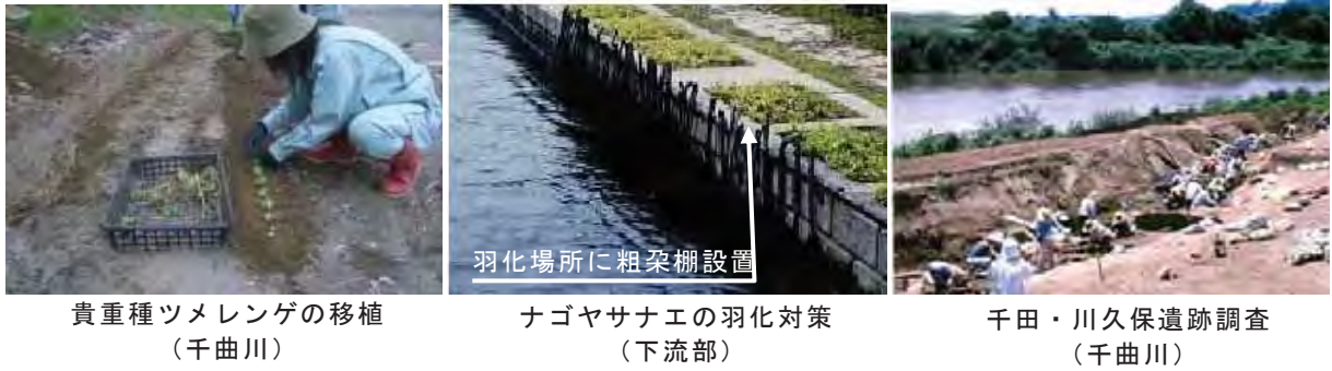
写真 67 工事による環境影響の軽減事例
