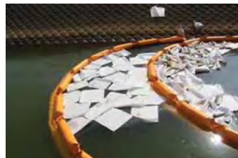
長岡市須川での油除去作業
