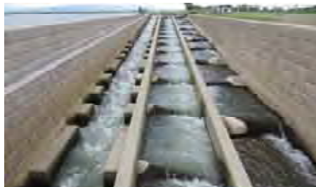
大河津可動堰魚道
