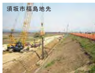
写真 12 漏水対策工事
