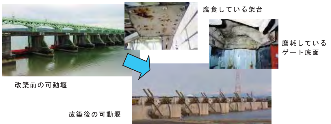
写真 18 大河津可動堰の改築状況
