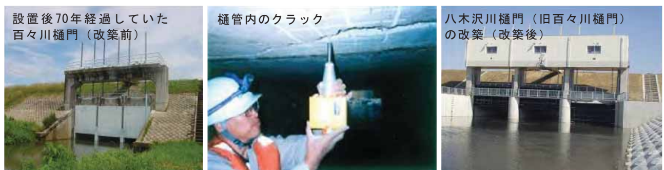
写真 19 八木沢川樋門(千曲川)の改築状況
