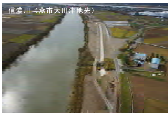
写真 52 堤防整備の実施例
