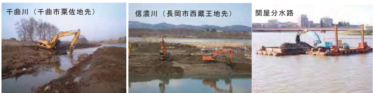
写真 53 河道掘削の実施例
