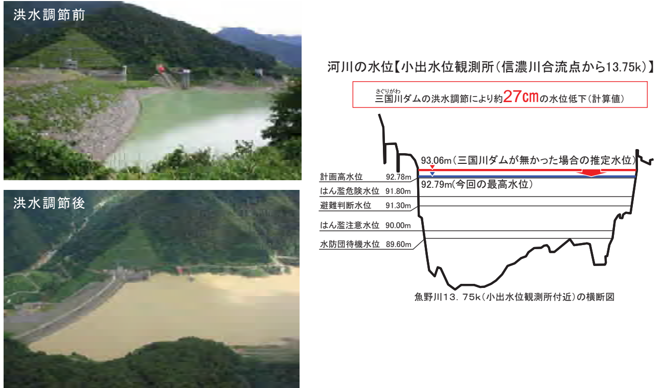
図14 平成23年7月洪水時における三国川ダムの洪水調節の様子
