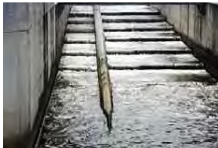
大島頭首工に設置された魚道
