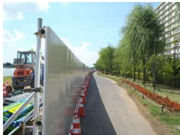
工事仮設フェンス
