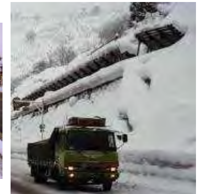
雪崩予防柵の設置
