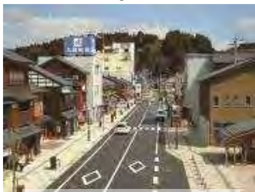
無電柱化による整備(能登町)
