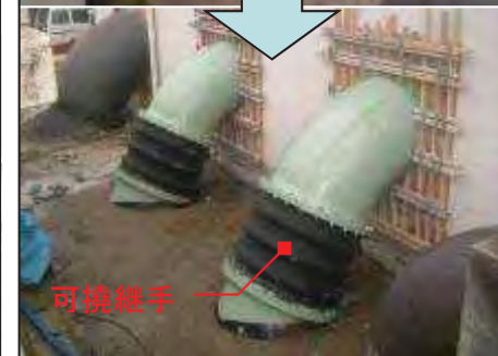
ポンプ場の耐震化(漏水防止) 〔金沢市〕
