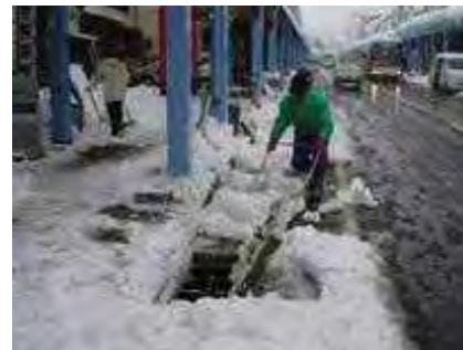
流雪溝の設置
