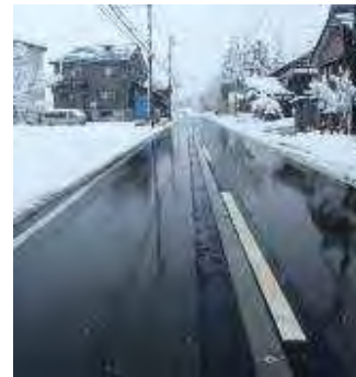
融雪施設の設置
