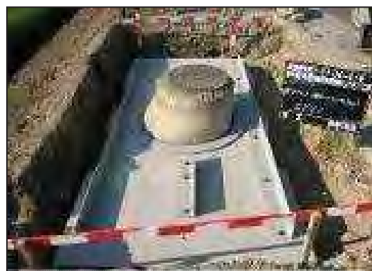
マンホールの浮上防止 (ハットリング工法の事例) 〔新潟県:阿賀野川流域下水道〕
