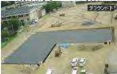
校庭雨水貯留施設整備の状況
