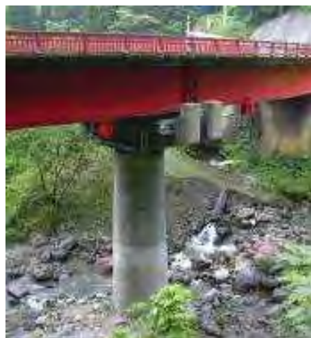
(コンクリート巻立てによる橋脚補強)
