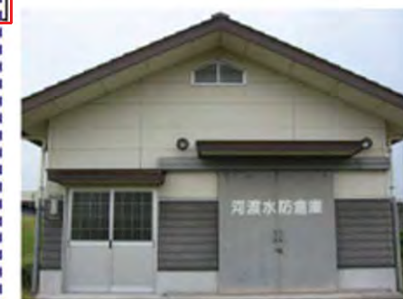
備蓄倉庫の整備
