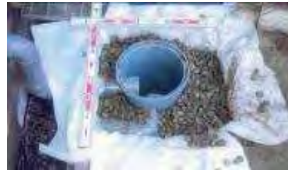
浸透ます設置民間助成の例(新潟市)
