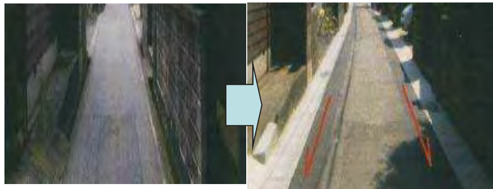
【避難路の整備】
