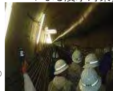
(雨水貯留管整備の事例) 〔新潟市〕
