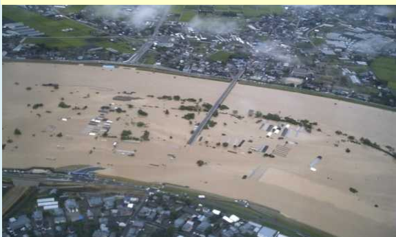
信濃川下流臼井橋周辺の状況(新潟市)
