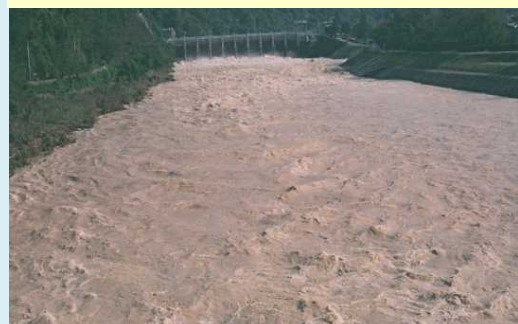
一斉に放水門を開けた庄川合口ダム
