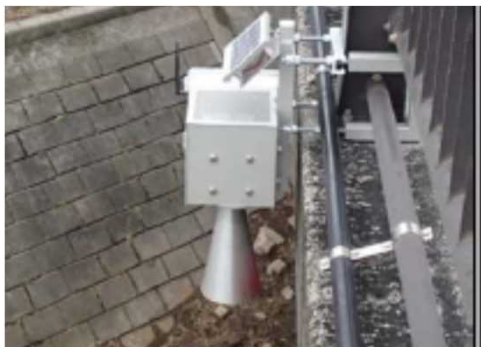
電波式水位計の例
