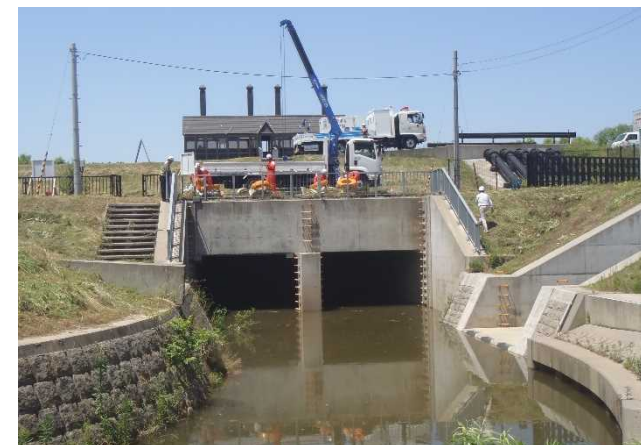
国による排水ポンプ車の訓練状況
